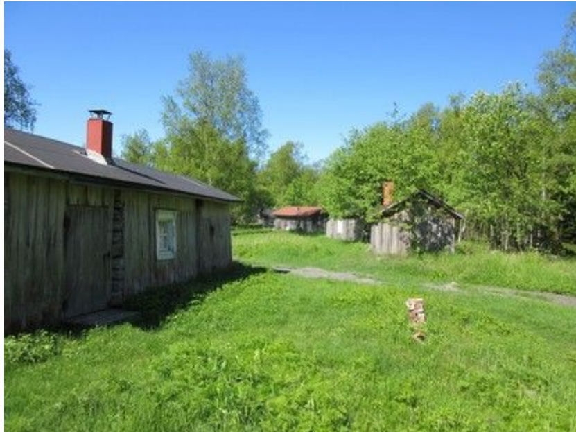
Rautaletto, entisen kalamökkikylän rakennuksia.
