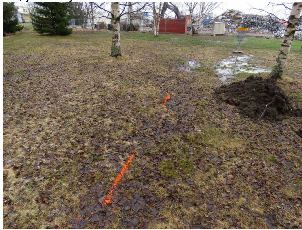
Kuva 2, nurmelle merkitty valokuitukaapeli.
