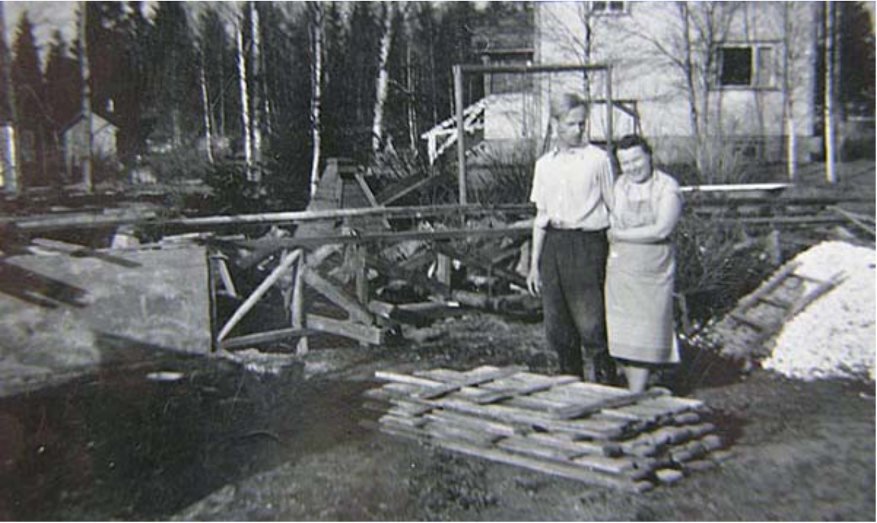
Isä ja Äiti katsastavat tyytyväisinä isän puisia mökinsiirtokiskoja. Kohta saapuu vinssi, jolla entinen kesämökki siirretään saunaksi uuden kivijalan päälle.
