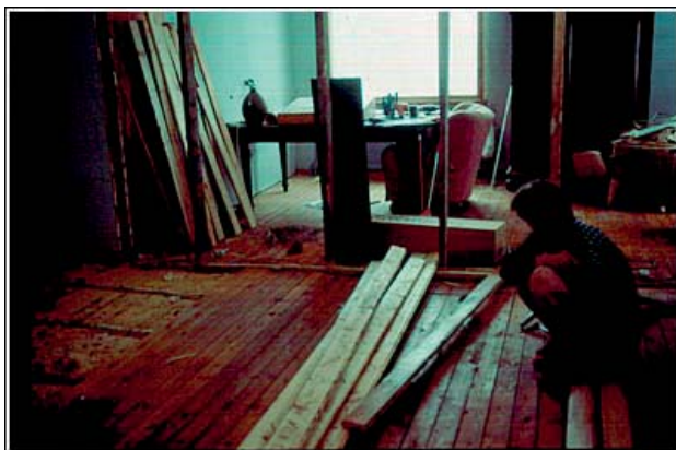
Olohuoneen väliseinä ja lattia purettiin, keskukslämmityksen putket ja patterit vaihdettiin uusiin.
