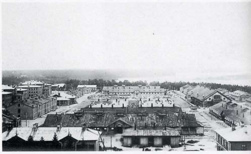
Kasarmialue kuvattuna idästä. Etualalla alipäälylystön asuinrakennusten katot. Niiden takana talleja ja keskusaukio. Vasemmalla Päätien varrella kaksikerroksinen venäläisten joukkojen rakentama tiilikasarmi. (EKM).
