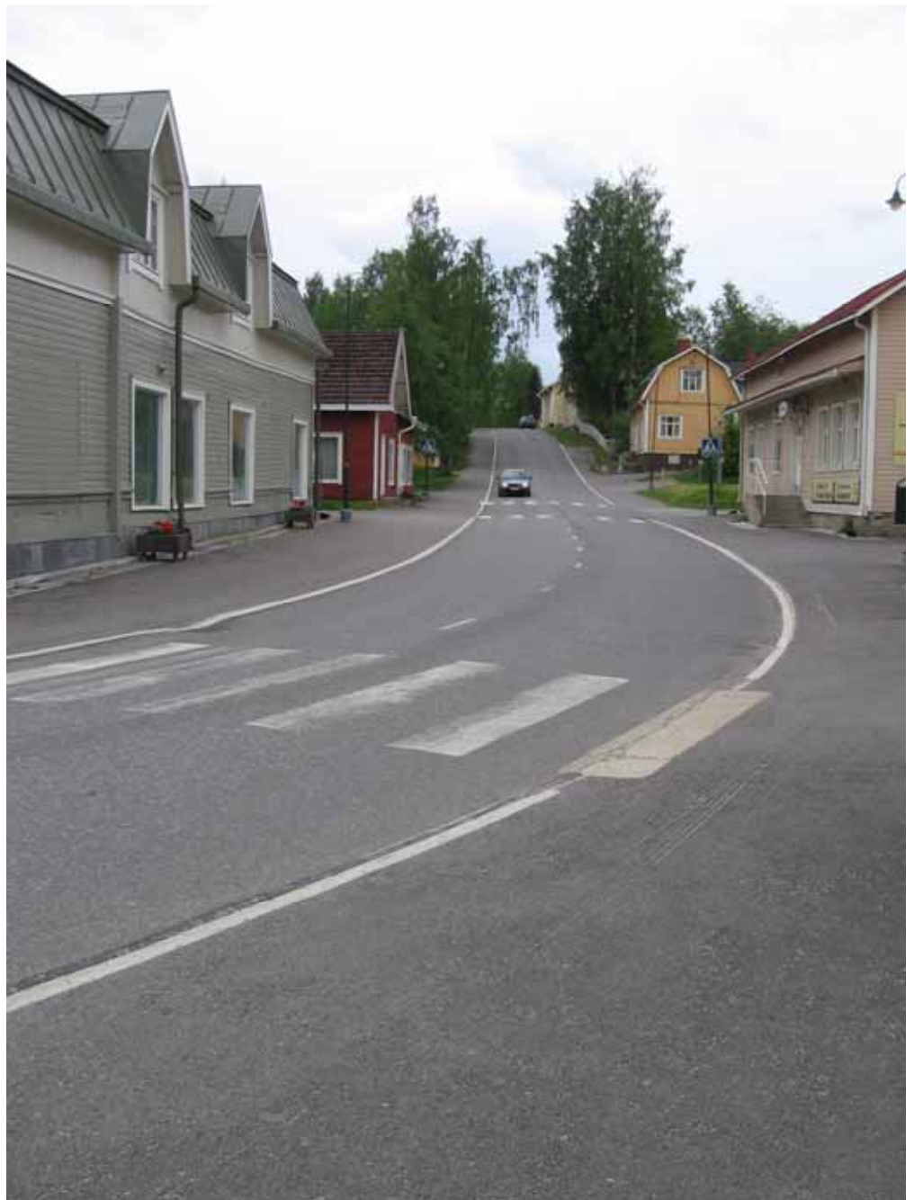
Kuva 30. Vanhantiellä kevyen liikenteen väylät on eroteltu ajoradasta vain maalauksella. Kuvassa oikeanpuoleinen väylä päättyy rinteessä ilman tien ylityskohtaa.
