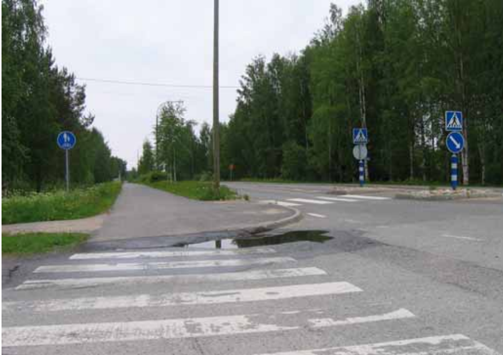
Kuva 31. Vanhatien ja Juuantien liittymässä pensaat peittävät näkemää keskustan suuntaan.
