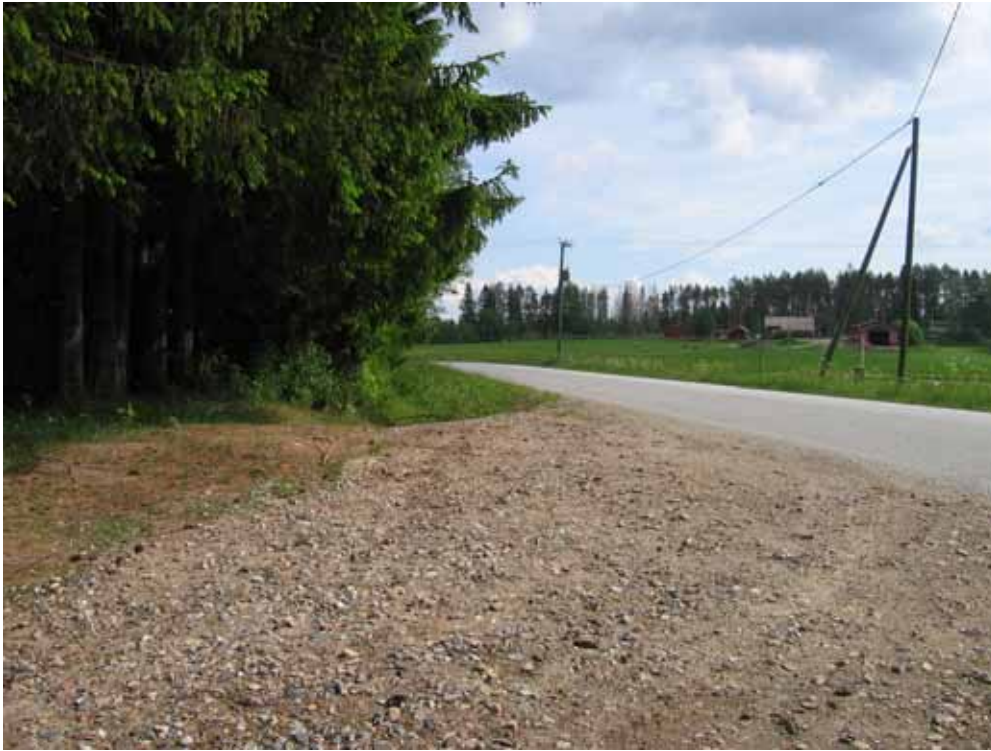
Kuva 41. Vuokon koulun liittymässä näkemä on huono.
