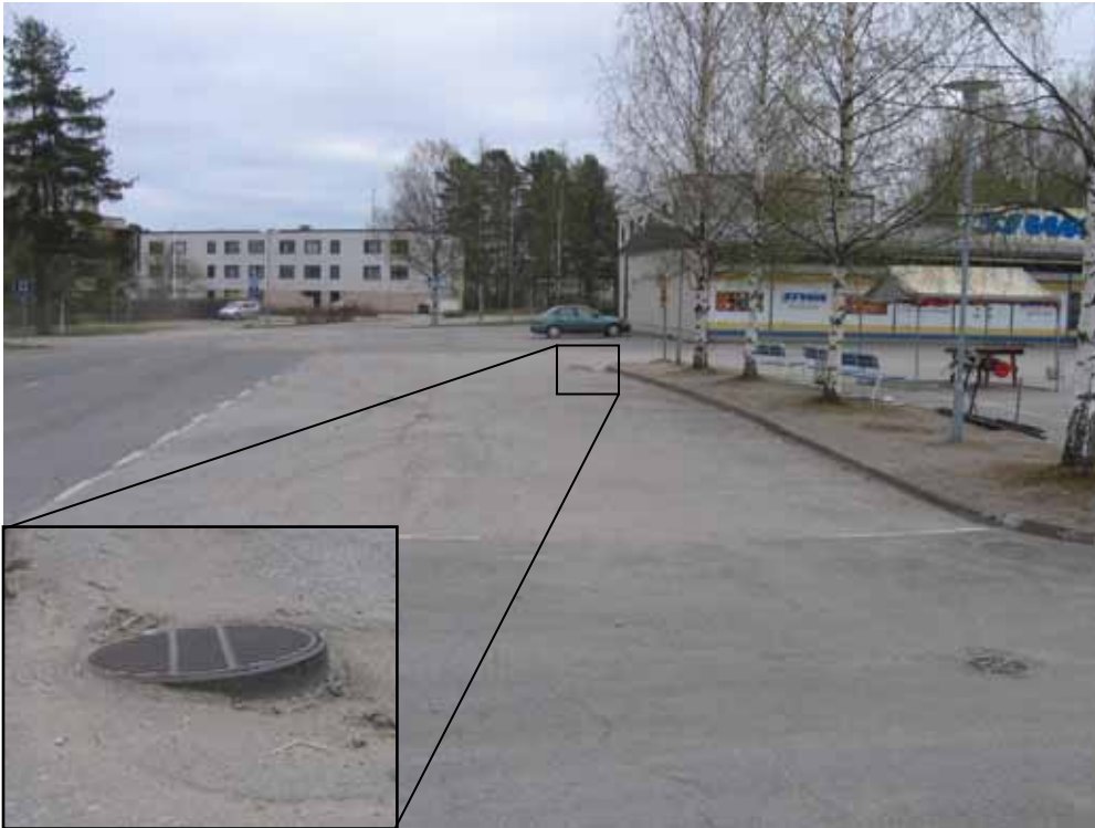
Kuva 38. Torin pysäköintipaikat muodostavat jäsentymättömän alueen, jossa on mm. routinut ja päällysteestä esiin noussut sadevesikaivo.
