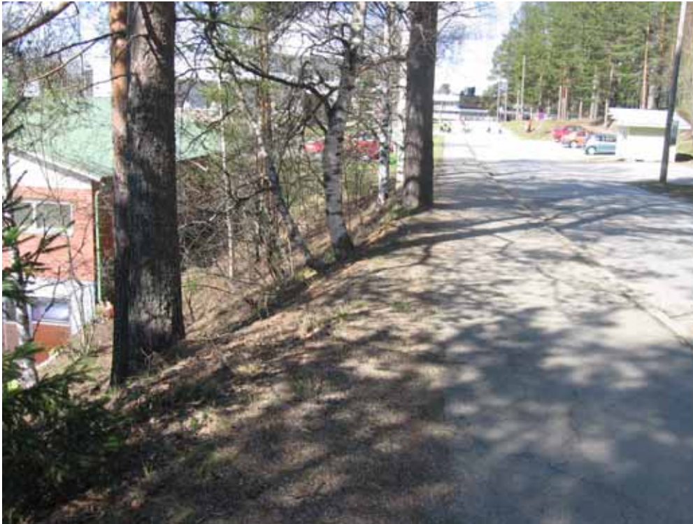
Kuva 30. Kevyen liikenteen väylä on Kunnantiellä kapea ja sijaitsee osin korkealla penkereellä.
