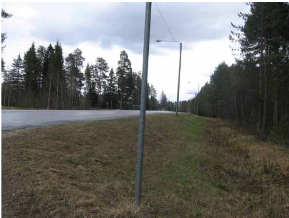
Kuva 32. Naulatien liittymän näkemä peittyy helposti, mikäli kesällä heinä ja talvella lumivalli pääsevät kasvamaan korkeiksi.
