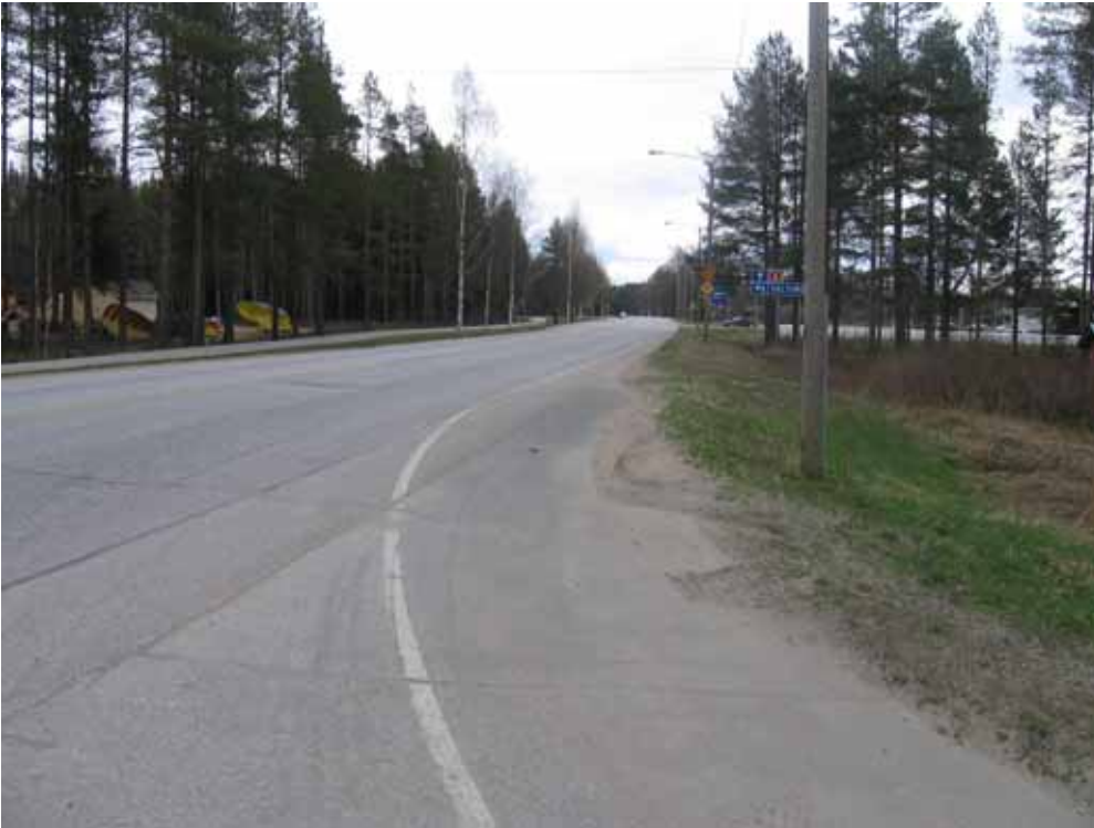
Kuva 33. Valtatiellä 6 Pajukosken liittymässä näkemät ovat hyvät, mutta liittymästä puuttuu väistötila. Läheisen huoltoaseman liittymässä on jo nykyisin väistötila.
