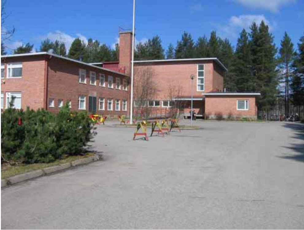
Kuva 28. Koulun pihan keskeisimpiä ongelmia ovat ahtaus, toimintojen puutteellinen erottelu sekä jättöliikennejärjestelyjen ongelmallisuus. Leikkialueita on eroteltu liikennealueista tilapäisin järjestelyin.
