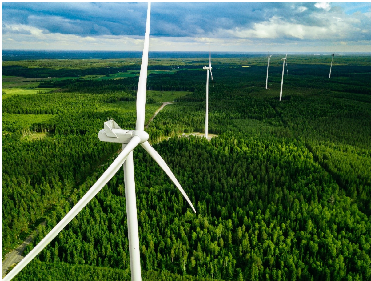
Kuva 32. Tuulivoima on yksi uusiutuva energiamuoto vähentää energian tuontiriippuvuutta. Kuva Kauhavalta, Pohjanmaalta. (Kuva: iStock)
