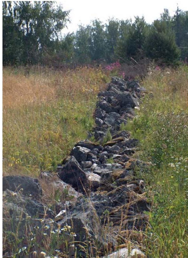
Myös vanhojen kiviaitojen kunnostukseen voi saada erityisympäristötukea. Rauennutta kiviaitaa kohteella 39e.
