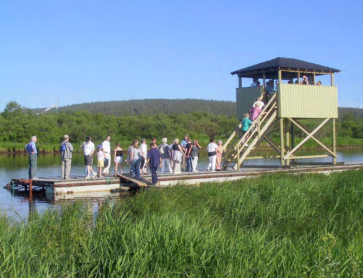
Suistoon on rakennettu virkistyskäyttöä ja matkailua palvelevia rakenteita. Koivusaaren kelluva lintutorni siirretään vuosittain voimakkaiden kevättulvien alta mannerrannalle. Kuva Marjut Kokko.
