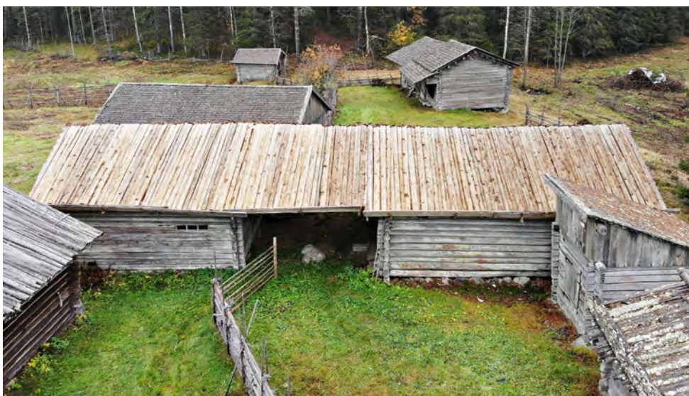
Uuden pihaton ja pihattoladon uusittu katto lokakuussa 2018 Malkojen määrä on sama kuin vuoden 1954 valokuvissa, mutta laatu vaihtelee vähemmän.. Vuoden 1954 valokuvissa näkyviä
