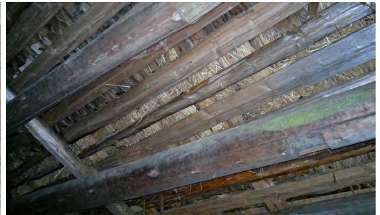
Museoviraston tekemiä korjaustöitä vuosituhannen vaihteesta kuvattuna vuonna 2014. Kaksi vasemmanpuoleista kuvaa: Riihen nurkan korjauksessa käytettiin kierrätysshirttä. Oikealla: Riilessä oli 1900-luvun alkupuolella tuohikatto, joka päällystettiin olkikatteella 1930-luvulla ja uusittiin pärekatteena ilmeisesti 1960-luvun alkuun mennessä. Pärekattoa 1990-luvulla uusittaessa kattoon jätettiin jäämiä edellisistä katteista.
