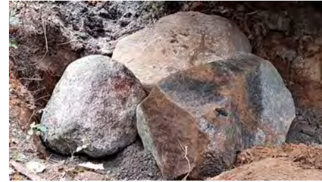
Tyynykivet murskeen päällä. Risto Holopainen, Lintukorpi Oy, 2019.
