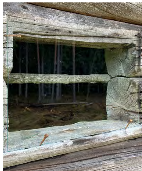
Ikkuna-aukkoon asennettiin lasi vuonna 2020.
