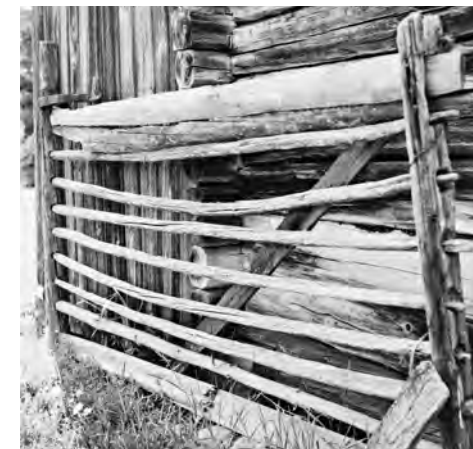
Portti vanhan navetan nurkalla vuonna 1974. Saranatolppa kääntyy vanhan pihaton seinään kiinnitetyn teräspannan varassa. KK7936:23. MV–MA, pääarkisto.
