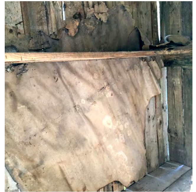
Ruokakellarin läöpän seinäpaperointia heinäkuussa 2015. Lääpän paperoinnin kunnostus päätettiin tehdä vasta läöpän katteen uusimisen jälkeen. Livady.
