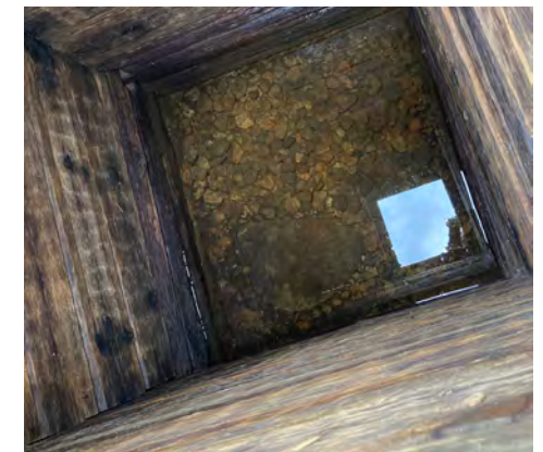
Kehän kolme alinta hirsikertaa säilytettiin vuoden 2019 korjauksessa. 2021.
