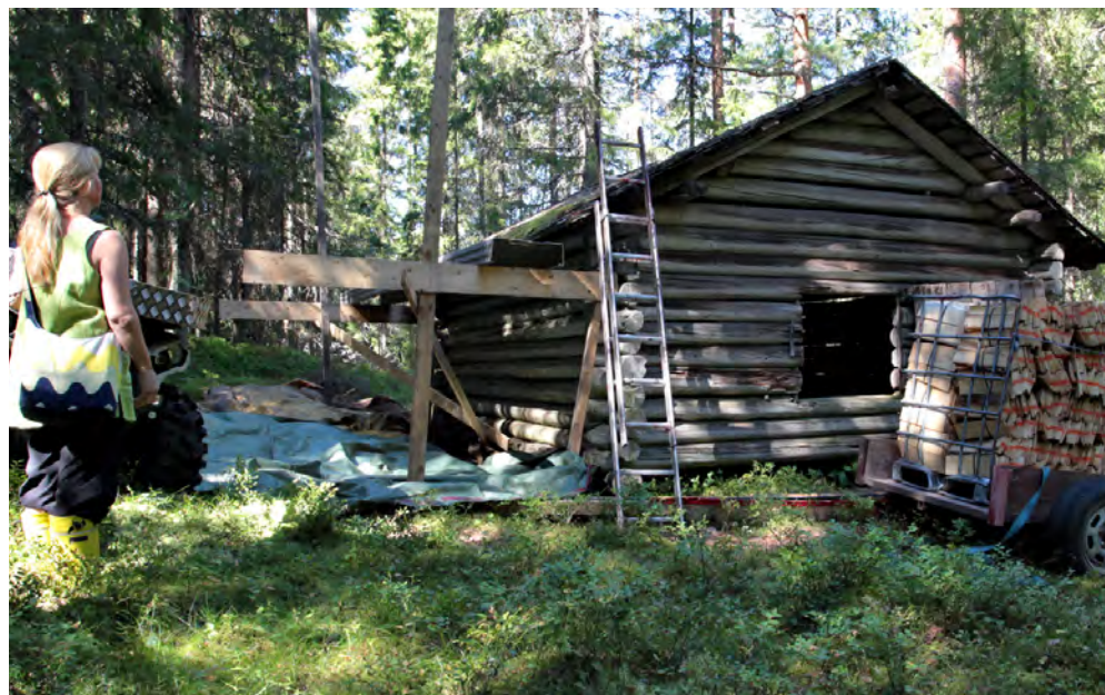
Päivi Eronen tarkastamassa suuren niitty-ladon pärekattotyömaata elokuussa 2015.
