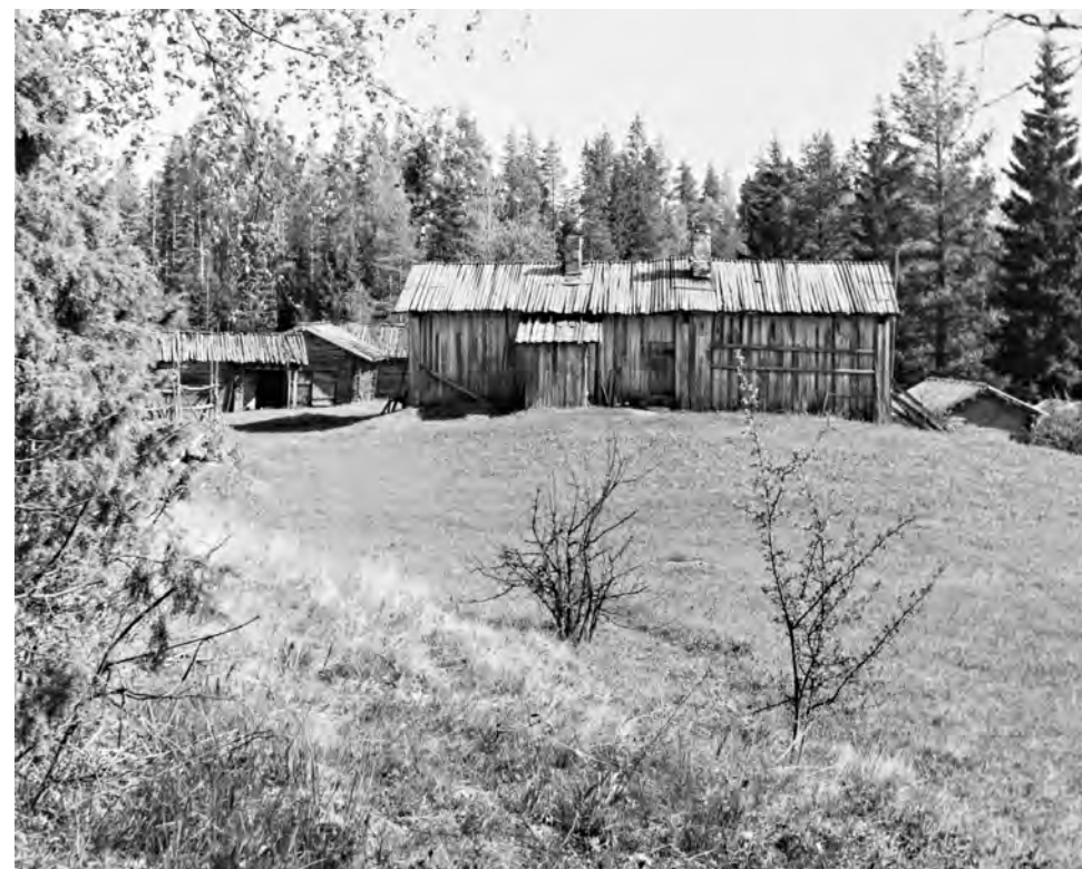
Näkymä Haukilammelle johtavan tien suulta torpalle vuonna 1974. KK7936:58. MV-MA, pääarkisto.
