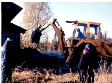
Päärakennuksen takapuolelle kaivetaan maastoleikkausta. Panu Kaila, 1980.
