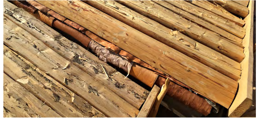
Päätyräystäällä osa tuohista ladotaan siten, että ne käpristyvät räystään suojaksi. 2018
