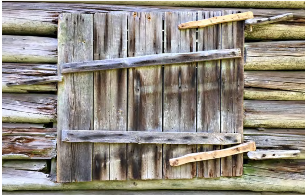
Ladon oven katajapuisten saranoiden uroskappaleet uusittiin kesällä 2015.
