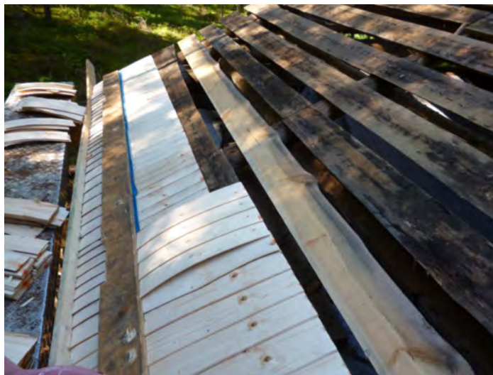
Karin Päre ja Puu uusi ladon pärekaton vuoden 2015 lämpimän ja kuivan kesän lopulla..
