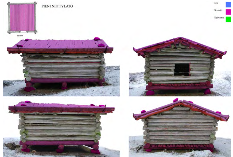
Ajoituskaavio Vuosien 1976–2013 välisenä aikana uusitut osat on merkitty sinisellä, vuosien 2014–2018 punaisella.
