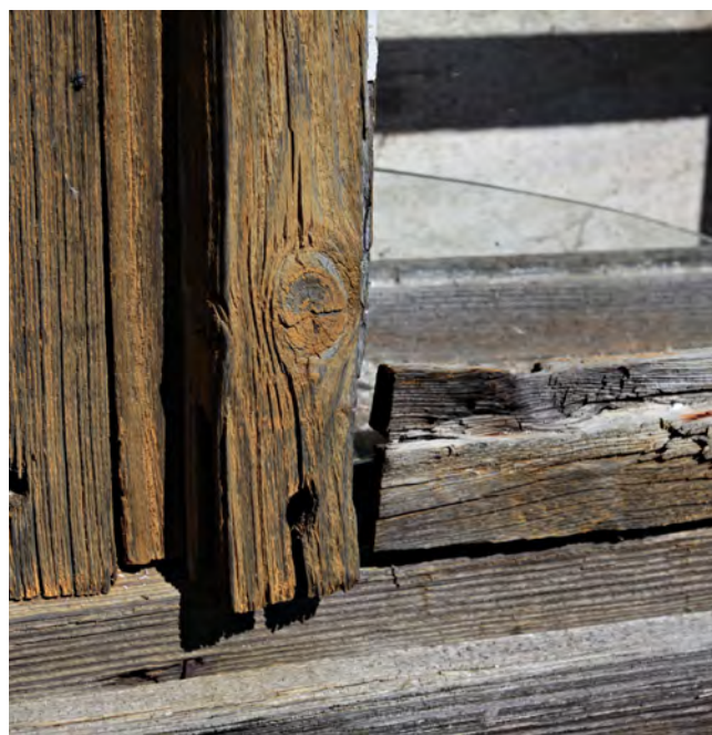
Yllä vasemmalla vaurioituneen puitteen alareuna vuonna 2014 ja oikealla kunnostettu ikkuna keväällä 2017. Oikeanpuoleinen puite asennettiin ylösalaisin, jolloin pahimmin vaurioitunut osa saa paremman suojan.
