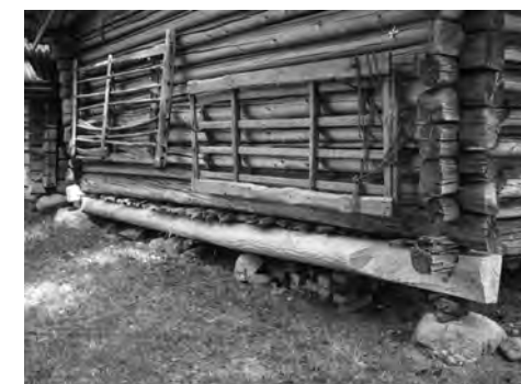
Pihattoladon lounaissivun alin hirsi uusittiin haapana vuonna 1997. RH0118564, MV, pääarkisto.
