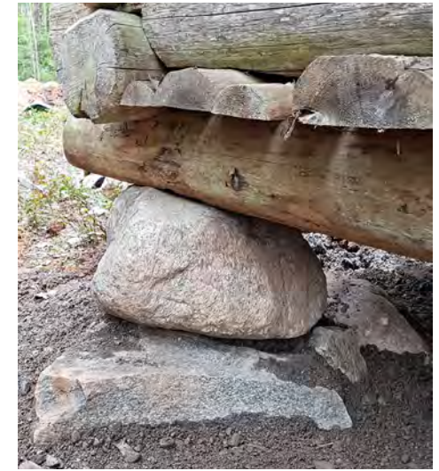
Uudet nurkkakivet ovat entisiä kookkaampia. Risto Holopainen, Lintukorpi Oy, 2019.
