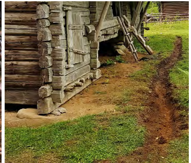
Viereisen kuvan kierrätysHIRSI UUDella nurkkakivellä vuonna 2020. Lintukorpi Oy.
