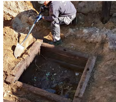
Kolme alinta varvia säästettiin. Risto Holopainen, Lintukorpi Oy, 2019.
