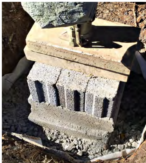
Pintamaan alla oli noin 70 senttiä hienoa silttiä. Suodatinkangas, murske ja kevytsoraharkot aseteltuina perustuskuoppaan.
