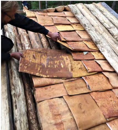
Kuvat yllä vasemmalla: Risto Holopainen latoo tuohia pienen niittyladon katolle elokuussa 2017. Tuohet ladottiin pystyvarveittain vähintään neljään kerrokseen. Alusmalkojen yläpäät viistettiin, jotta tuohille saatiin myös harjalla hyvä alusta. Päälysmalkojen alapäät teroitettiin paremman tuuletuksen saamiseksi räystäälle. Malat eivät risteä harjalla.
