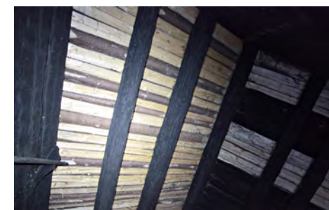
Yllä vasemmalla: Alkuperäiset, vuonna 1996 käytöstä poistetut rappuset varastoituna saunaan. Yllä oikealla: Vuoden 1996 korjauksessa uusitut alusmalat erottuvat vaaleina. 2014
