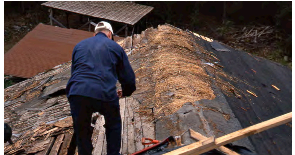
Alla kunnostettu Riihi ja yllä vanhan kattorakenteen purkutyötä vuonna 2000: "Peltikatteen alla oli vanha pärekate, huopakatetta, vanhan olkikatton rippeitä harjalla [...] katemateriaalina oli käytetty myös muovia ja avattuja pahvilaatikoita." 1 Raimo Autio.
