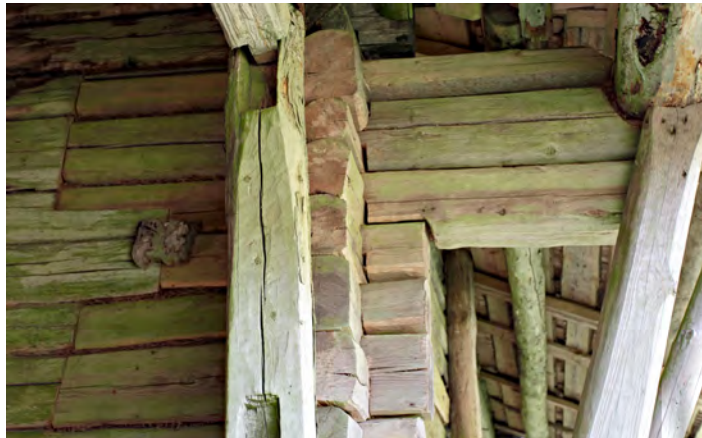
Museoviraston tekemiä korjaustöitä vuosituhannen vaihteesta kuvattuna vuonna 2014. Kaksi vasemmanpuoleista kuvaa: Riihen nurkan korjauksessa käytettiin kierrätysshirttä. Oikealla: Riilessä oli 1900-luvun alkupuolella tuohikatto, joka päällystettiin olkikatteella 1930-luvulla ja uusittiin pärekatteena ilmeisesti 1960-luvun alkuun mennessä. Pärekattoa 1990-luvulla uusittaessa kattoon jätettiin jäämiä edellisistä katteista.
