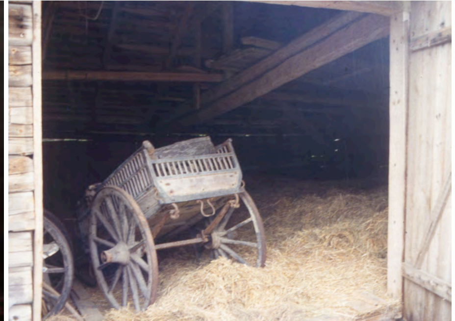
Makasiini tyhjennettiin heinistä vuoden 1995 korjaustöiden yhteydessä. Risto Holopainen.
