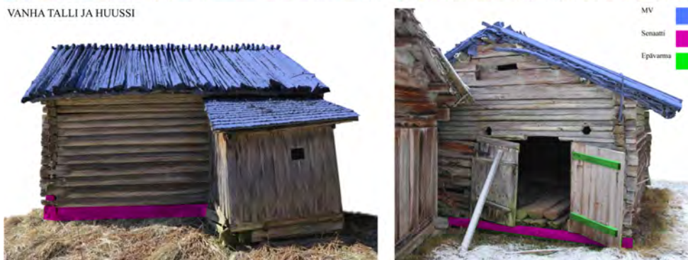
Ajoituskaavio. Vuosien 1976 ja 2013 välisenä aikana uusitut tai muokatut osat on merkitty sinisellä, myöhempien vuosien punaisella. Punainen piste osoittaa hirsiseurannan kilven paikan.
