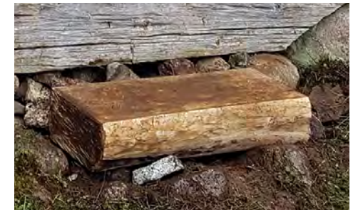
Porrasaskelma uusittiin vuonna 2020.
