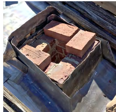
Savupiippujen helmoista tehtiin lyijypellillä vedenpitävät.
