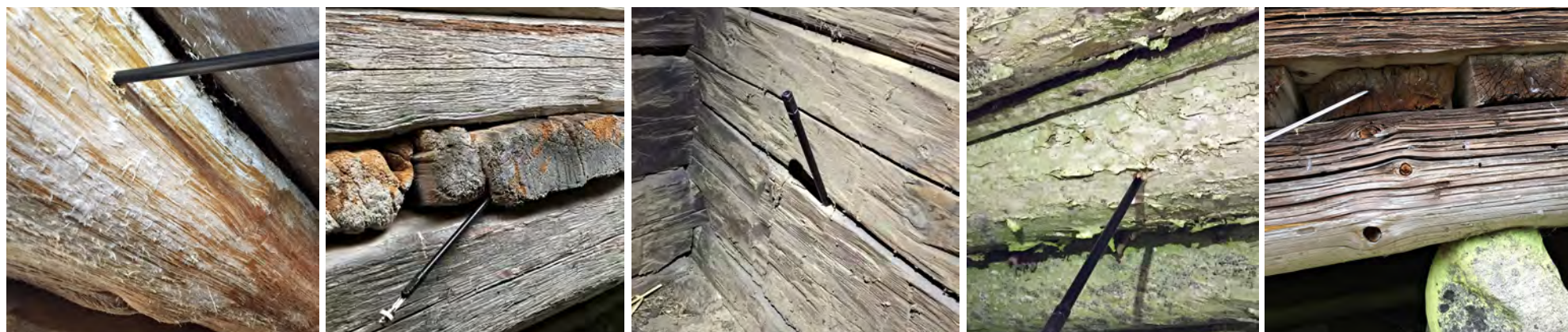
Ruoka-aitan mäntynäytteet otettiin lattiahalkjista: vasemmalla näytteen 2 ja oikealla näytteen 1 ottopaikka. Muut Ruoka-aitan näytteet otettiin seinähirsistä, jotka kaikki näyttävät tehdyn nuorista kuusista.
