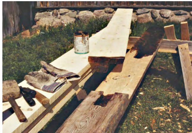
Yllä vasemmalla porstuan lattialankkujen korjausta. Kalervo Virkki, 1996. Yllä oikealla porstuan lattia altapäin kuvattuna kesällä 2015.
