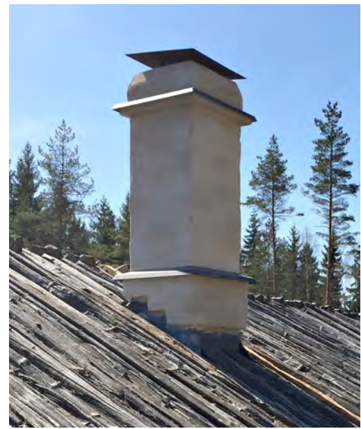
Kamarin piippu korjaustyön jälkeen vuonna 2017. Piippujen ylimmistä tiilivarveista jäi puuttumaan niissä vanhastaan olleet ja suunnitelmiin piirretyt savuaukot. Puute päätettiin korjata malkakaton uusimisen yhteydessä, jotta vältytään ylimääräiseltä telinetyöltä.
