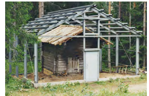
Saunan suojarakennus purettiin vuonna 1996. Kalervo Virkki.
