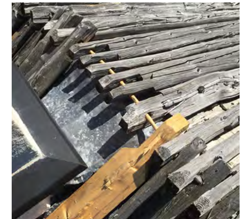
Helmapellitys ulotettiin harjan yli. Parittomiksi jääneet malat ripustettiin uudella puikolla viereisistä maloista.
