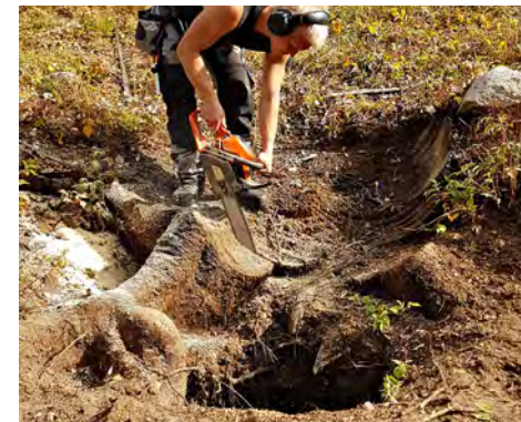
Suuritöisin vaihe kaivon kunnostustyössä oli kaivon kiinni kasvaneen kuusen juurien raivaaminen rakenteiden tieltä. Risto Holopainen, Lintukorpi Oy, 2019.
