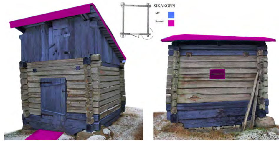
Ajoituskaavio. Vuosien 1976 ja 2013 välisenä aikana uusitut tai muokatut osat on merkitty sinisellä. Pärekatto ja lasi uusittiin vuonna 2019, porrasaskelma vuonna 2020.
