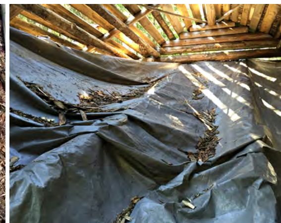
Irtaimiston suojausta pärekaton uusimisen yhteydessä elokuussa 2015. Katolta putoava jäte ohjattiin lautojen varaan lasketun pressun kautta ovensuuhun.
