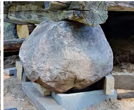
Survin perustustöitä vasemmalta lukien: Lattianiskan luoteispää, kehikon itänurkka ja kehikon etelänurkka. Lintukorpi Oy. 2020.
