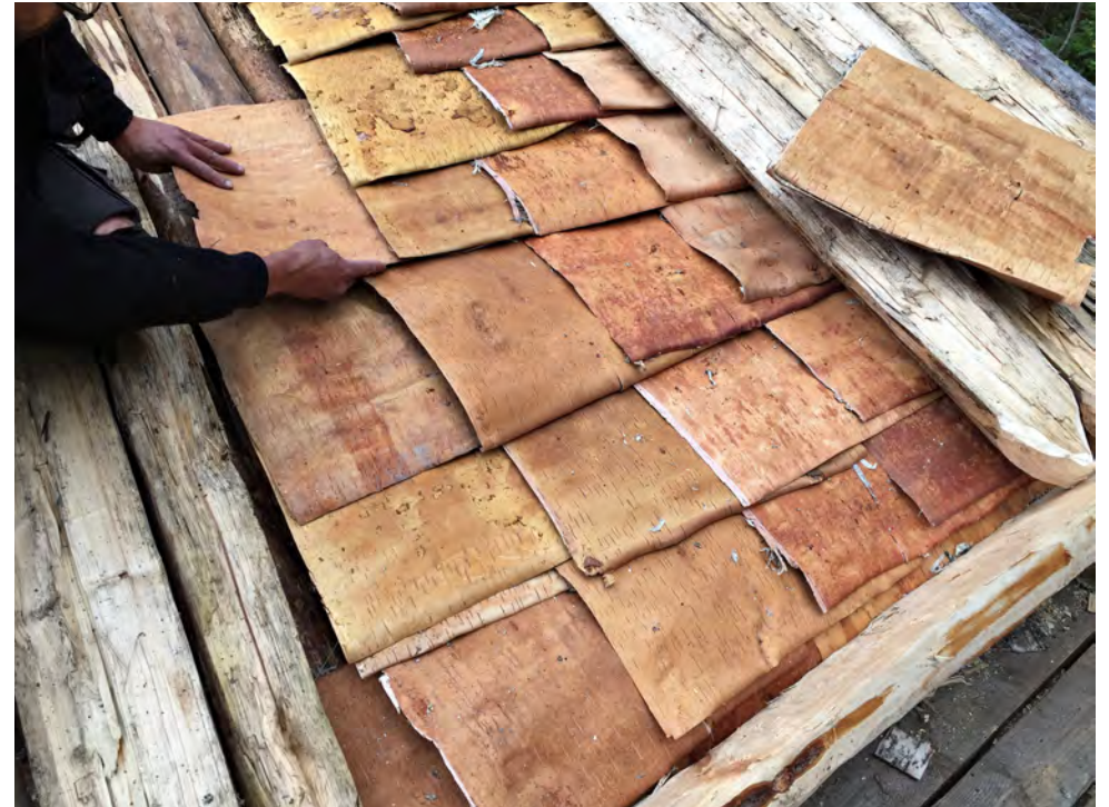
Pienen niityladon katto ladottiin pystyvarveina nelinkertaiseksi. Pystyvarveina latomisen etuna on se, että tuohet saadaan nopeammin malkojen alle. 2017.
