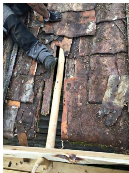
Uusien koukkujen kohdalta vanha tuohitus puretaan asennuksen ajaksi pois ja ladotaan asennuksen jälkeen takaisin. Pihattolato, 2018.
