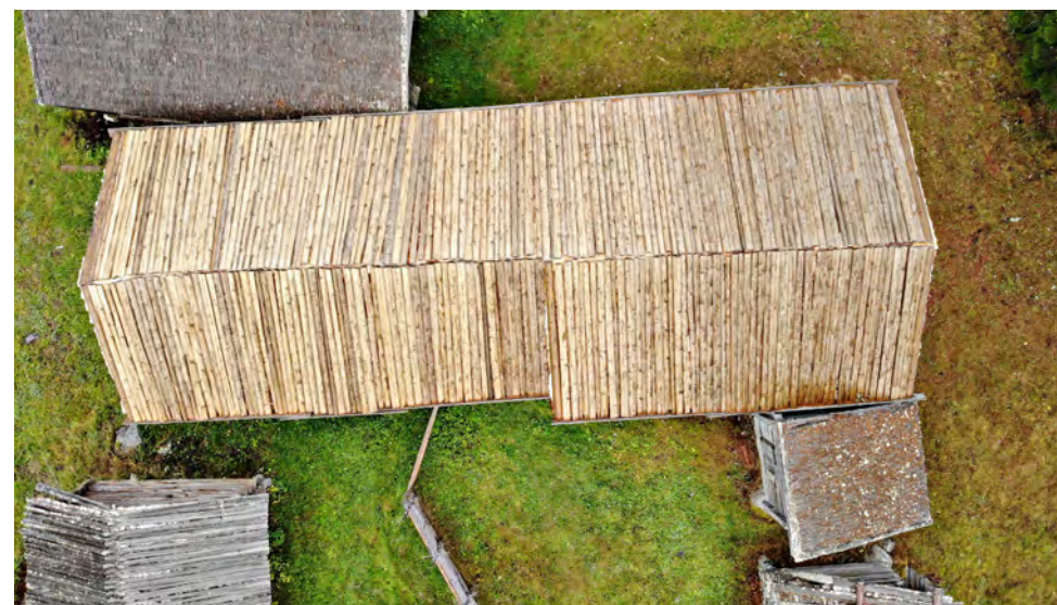
harjalautoja ei tehty uuteen kattoon, koska lautojen tulkittiin olleen paikkaus – ei siis osa alkuperäistä katemallia.
