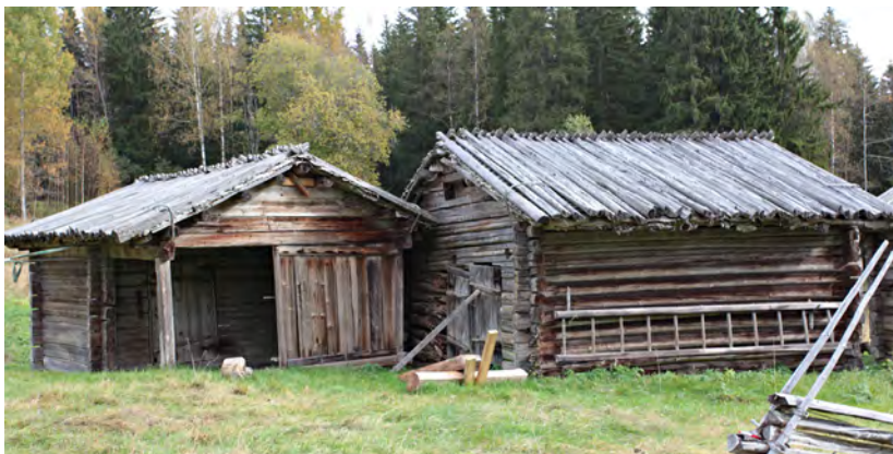
Tallit vuonna 2014 uuden tallin kunnostuksen aikana.
