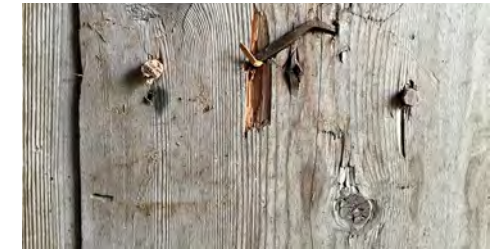
Uuden tallin ovi ryhdistettiin ja pienojen puunauloja uusittiin vuonna 2019.
