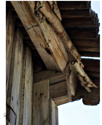
Yllä Asuinrakennuksen ja aittojen harjapuikollisia malkakattoja lokakuussa 2018. Alla Asuinrakennuksen räystäshirren tukeutuminen konsoliin rakennuksen itänurkalla, 2014.
