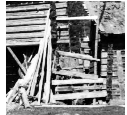
Halkovajan ja sikakopin väli on tukittu laudoituksella. Laudat on päistään naulattu tolppiin, joista toinen on antennitolppa. KK3055-134, det., 1954, MV, pääarkisto.
