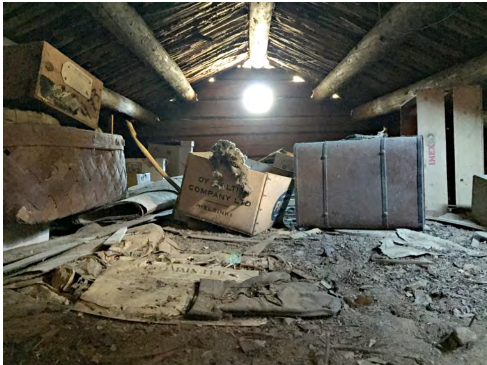
Kamarin vintillä olevaa esineistöä savupiipun korjauksen aikaan vuonna 2017.
