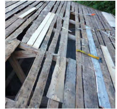
Makasiinin pärekattotyömaa kesällä 2015. Kaiken kaikkiaan kymmenisen ruodelautaa uusittiin. Karin Päre ja Puu.
