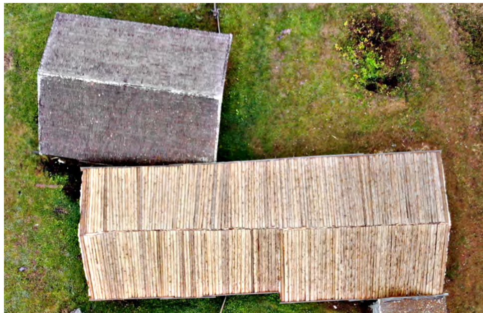
Vanhan pihaton räystääs jää uuden pihaton räystäään alle. Vanhassa pihatossa on pärekatto. 2018.
