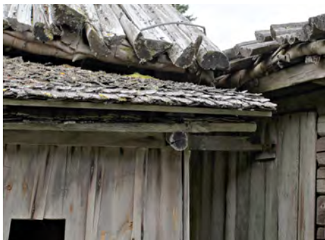
Huussin vanhan pärekaton päälle tehtiin uusi pärekatto 1990-luvun lopulla.
