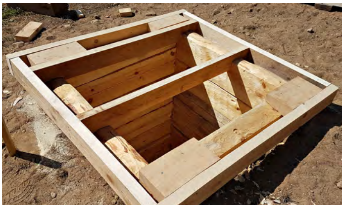
Kansirakenteet mahdollistavat kannen tuulettumisen. Risto Holopainen, Lintukorpi Oy, 2019.
