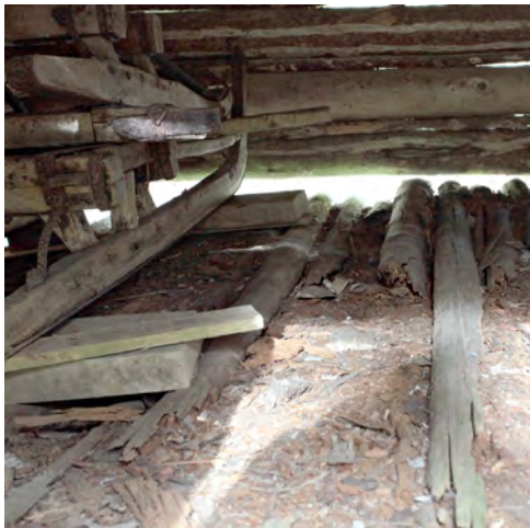
Pieni niittyladon permantorakenteita vuonna 2014. Kuvassa näkyvien permantohaljasten alta löytyi varhaisempi permanto.
