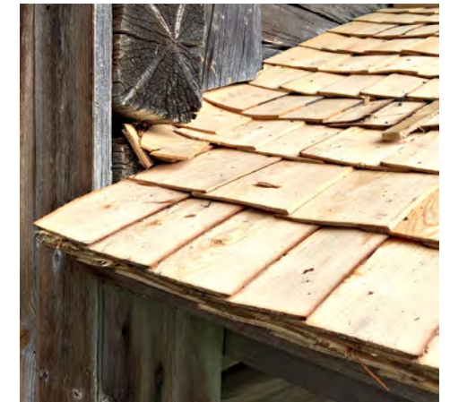
Kuistin uusittua pärekattoa kesällä 2015. Pärekattoon tehtiin hirsikehikon nurkkien kohdalle vastakaadot.
