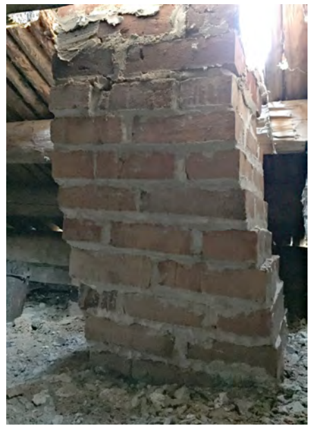
Kamarin piippu korjaustyön jälkeen vuonna 2017. Piippujen ylimmistä tiilivarveista jäi puuttumaan niissä vanhastaan olleet ja suunnitelmiin piirretyt savuaukot. Puute päätettiin korjata malkakaton uusimisen yhteydessä, jotta vältytään ylimääräiseltä telinetyöltä.
