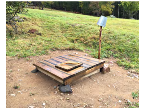
Pihakaivo kunnostettuna lokakuussa 2019.
