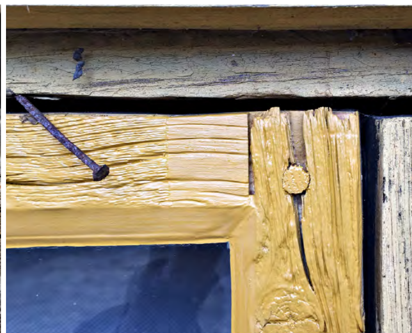
Yllä vasemmalla vaurioituneen puitteen alareuna vuonna 2014 ja oikealla kunnostettu ikkuna keväällä 2017. Oikeanpuoleinen puite asennettiin ylösalaisin, jolloin pahimmin vaurioitunut osa saa paremman suojan.
