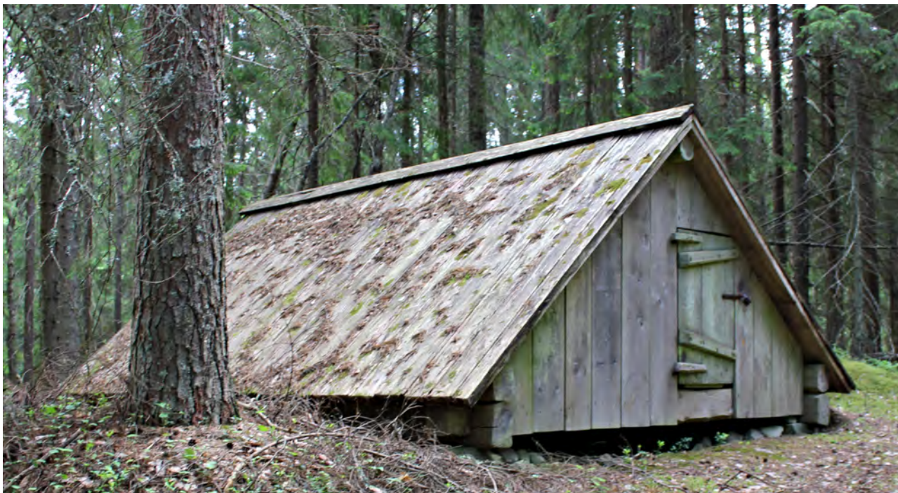
Maakellari kesällä 2014. Kellarin ympäristö oli metsittynyt ja haapapuisen lautakaton käyttöikä sitä myöten lyhentynyt.
