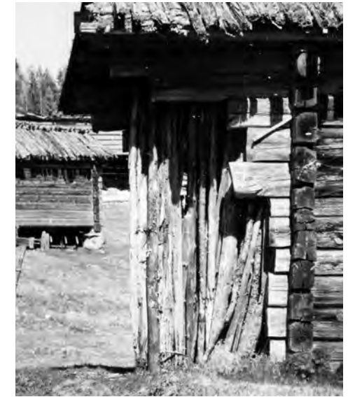
Saunan päätykatoksen alle, lounaan puoleisen seinän jatkoksi, on asetettu vaihtelevan vahvuisia seipäitä ja haljaksia peseytymisen tai vilvoittelun suojaksi. Suojaseinämä nojaa yläpäästään päätykatoksen konsoliin, alapään levätessä maata vasten. KK3055-151, 1954, MV, pääarkisto.
