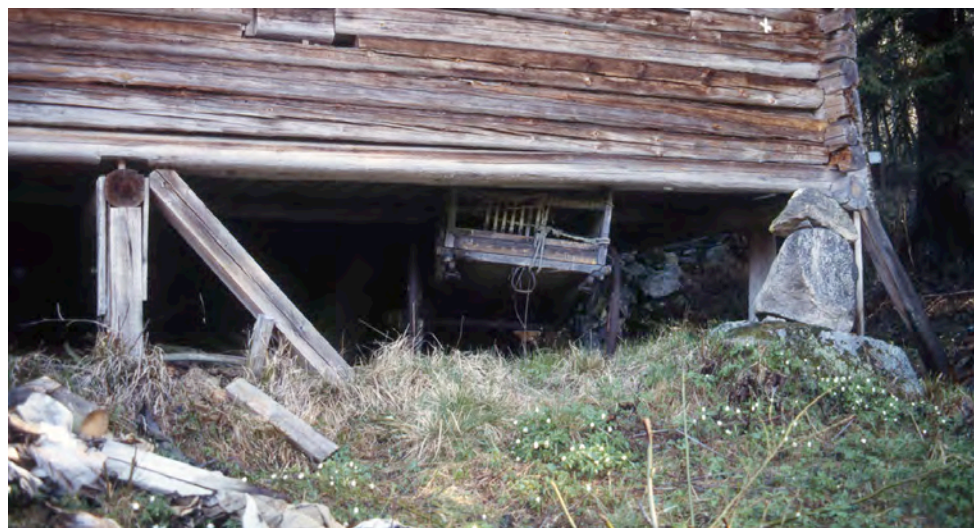
Makasiinin alustaa vuonna 1995. Makasiini on tuettu pönkillä paikoilleen. Risto Holopainen.
