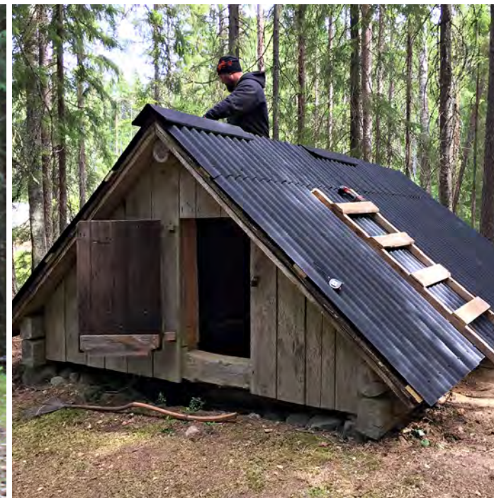
Profiilibitumihuopakatetta asennetaan haapalautakatteen päälle kesällä 2018.
