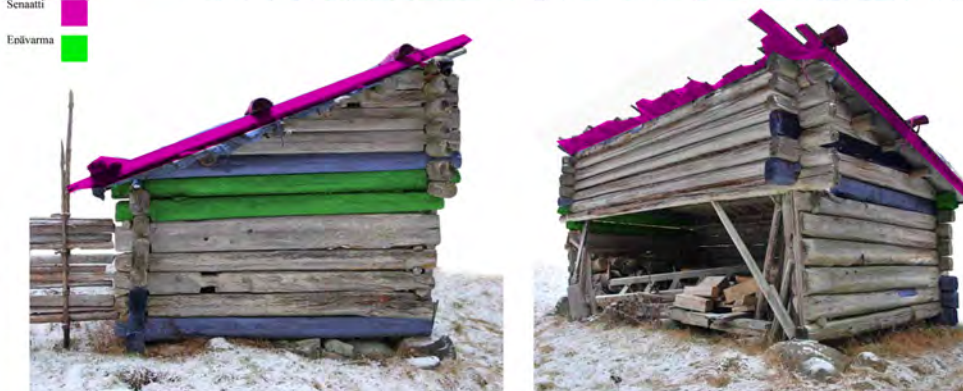
Ajoituskaavio. Vuosien 1976 ja 2013 välisenä aikana uusitut tai muokatut osat on merkitty sinisellä, vuosien 2014 ja 2018 punaisella.
