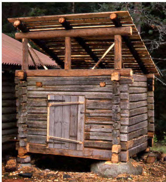
Sikakoppi vuonna 2000. Vasemmalla runko korjattuna ja oikealla korjauksen viime vaiheessa. Raimo Autio.
