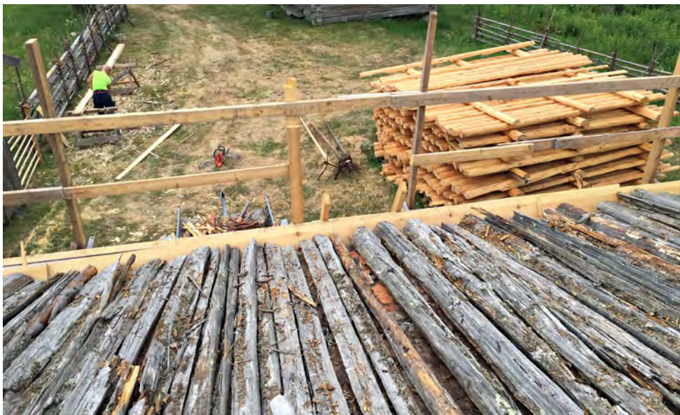
Mäntypuiset räystäslaudat asennettiin siten, että sydänpuuosuus vastaa, kuvassa vielä vanhoihin, kuusipuisiin malkoihin. Kuviolta numero 1 kaadetut malka-aihiot kuorittiin kuorimaraudoilla, halkaistiin kirveillä ja kiiloilla ja taapeloitiin rihipihan perunakuopan päälle odottamaan käyttöä. Kuvan keskellä kuusipuisia koukkuaihoita, vasemmalla kantataan räystäslauta-aihiota.
