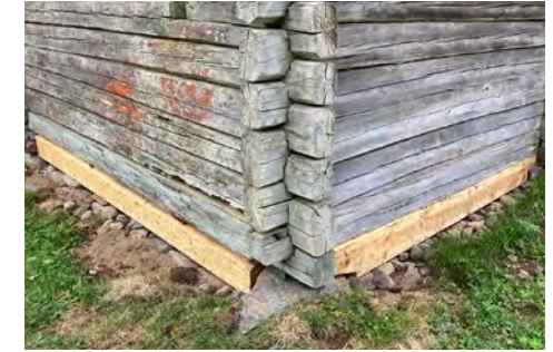
Uuden tallin luoteis- ja koillissivujen maahirret uusittiin vuonna 2022.
