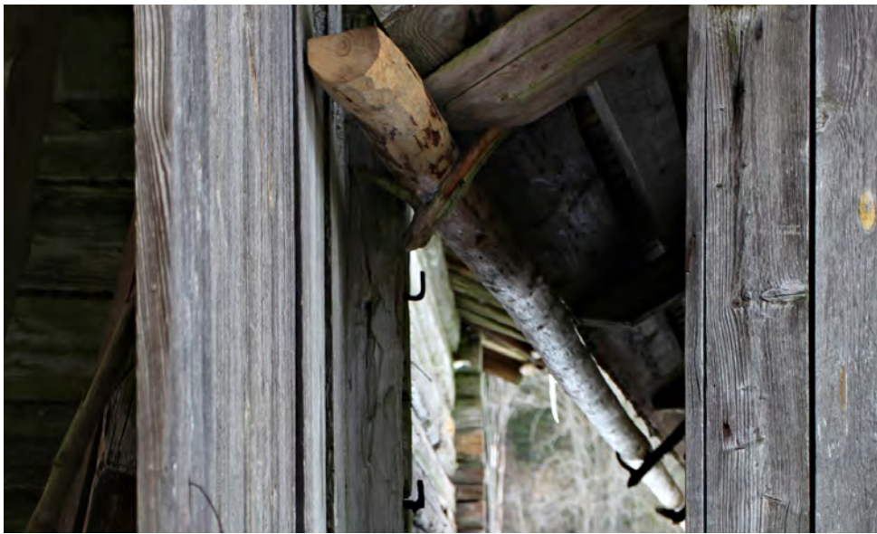
Lintukorpi Oy uusi pihattojen välissä olevan vesikourun vuonna 2015.
