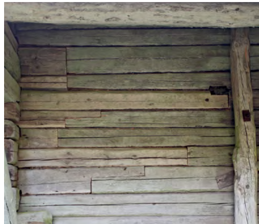
Museoviraston tekemiä korjaustöitä vuosituhannen vaihteesta kuvattuna vuonna 2014. Kaksi vasemmanpuoleista kuvaa: Riihen nurkan korjauksessa käytettiin kierrätysshirttä. Oikealla: Riilessä oli 1900-luvun alkupuolella tuohikatto, joka päällystettiin olkikatteella 1930-luvulla ja uusittiin pärekatteena ilmeisesti 1960-luvun alkuun mennessä. Pärekattoa 1990-luvulla uusittaessa kattoon jätettiin jäämiä edellisistä katteista.
