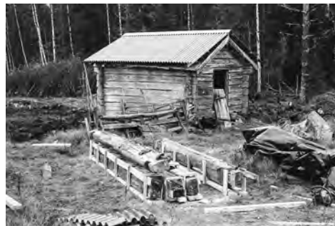
Akanakopin hirsia lähdössä kyllästettäväksi vuonna 1984. RH058729, MV, pääarkisto.
