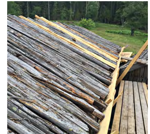
Vanhat päällysmalat poistettiin suojaamasta vanhaa tuohitusta vasta sitä mukaa, kun uutta tuohitusta ladottiin. Myös uusien malkojen alapääät jätettiin suoralle sahapinnalle. Livady
