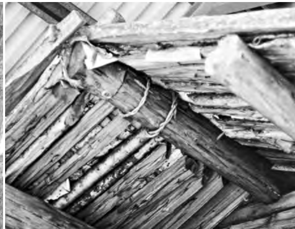
Saunan kurkhirren alkuperäinen korjaus vuoden 1996 kuvassa. RH0117824, MV, pääarkisto.
