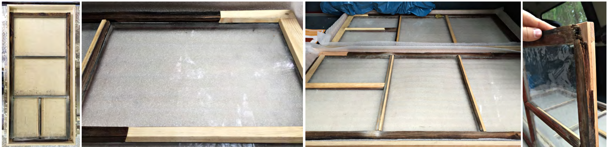
Kamarin kaakkoisikkunan ulkopuite suojalaatikossa Lintukorpi Oy:n verstaalla ennen kunnostusta kesäkuussa 2015 (vas.) ja puuvalmiina lokakuussa 2015.
