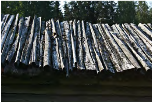
Pihaton ja ladan vesikaton kunnostustyöt käynnissä vuonna 2000. Raimo Aut
