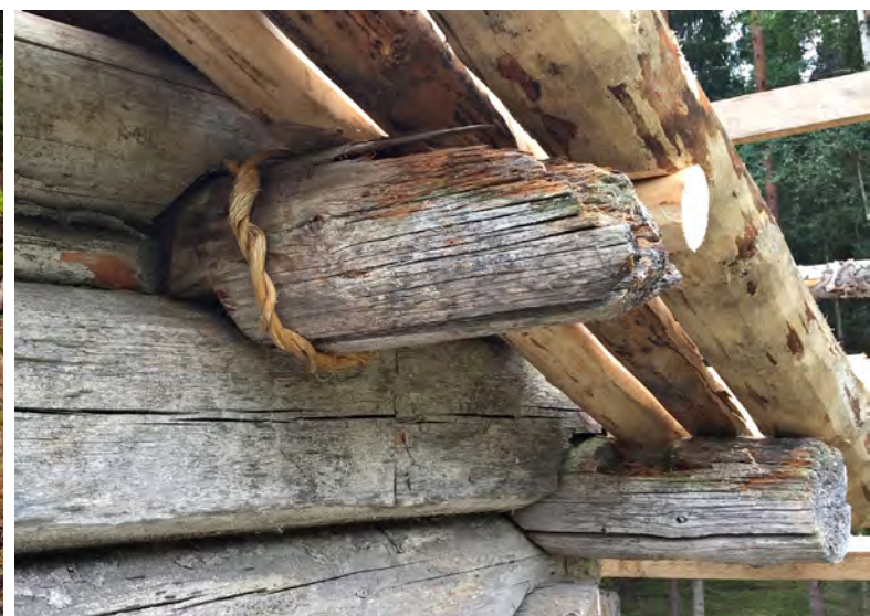
Alla: Pienen niittyladon vuoliaisten vaurioituneet päät saatiin räystäään alle suojaan tukemalla räystäät vanhojen vuoliaisten kylkeen asennettuihin apurakenteisiin.
