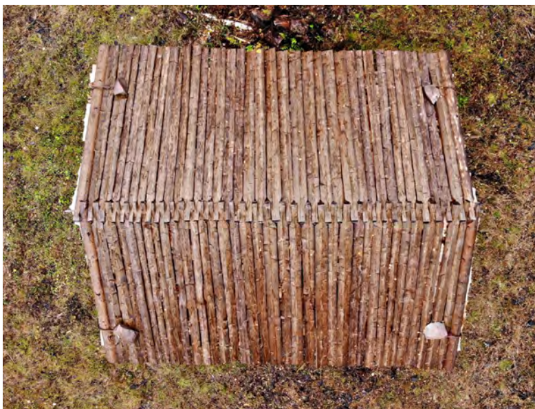
Kuvat yllä ja alla: Saunan katon reunavitsasten päät on työnnetty päällysmalkojen alle. Päällysmalkojen koholle jääminen on estetty painokivillä. 2018.
