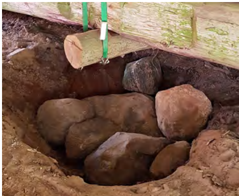
Survin perustustöitä vasemmalta lukien: Lattianiskan luoteispää, kehikon itänurkka ja kehikon etelänurkka. Lintukorpi Oy. 2020.
