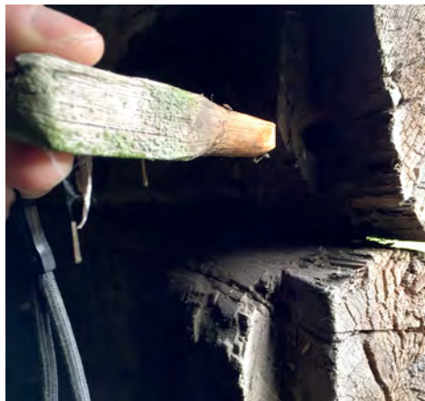
Sontaluukun tappi vuonna 2019 ja sontaluukkusuunnitelma (Marko Järvitalo, 2000). Repro, MV, käsiarkisto.
