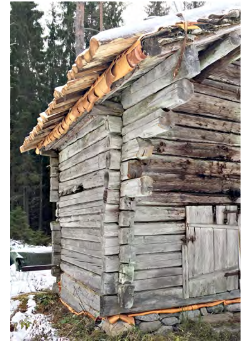
Sauna korjaustöiden jälkeen syksyllä 2017.
