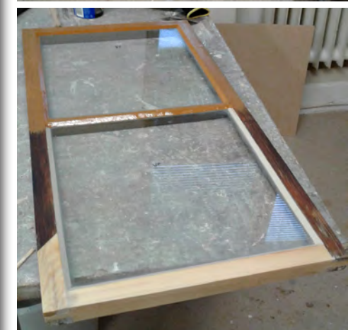
Alla koillispäädyn ikkunat puukorjausten ja lasituksen jälkeen. Arvonkorjaajat Oy, 2018.
