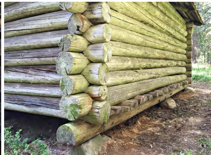
Suuri niittylato oikaistiin ja nostettiin kesällä 2015.
