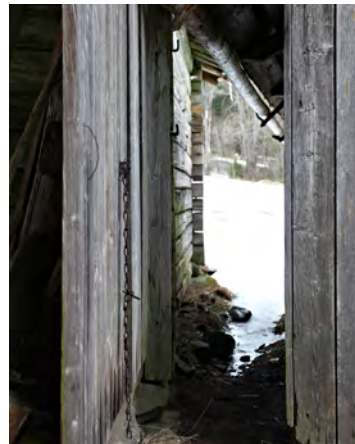
Uuden pihatton etelänurkalla, pihatton välisessä solassa, on saranapuu, jossa on kolme saranatappia. 2015.
