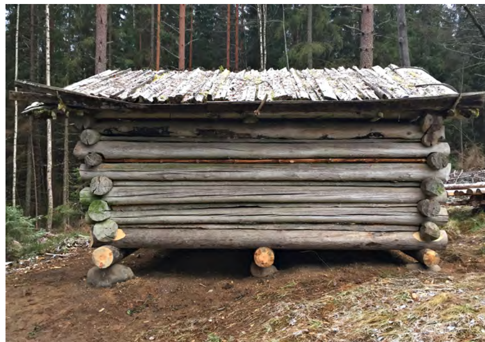
Lato syksyllä 2016. Uusittu välimalka erottuu ruskeana harmaalla seinällä.
