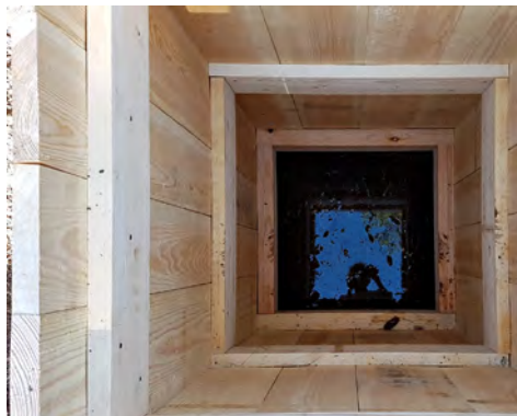
Kunnostettu saunakaivo syksyllä 2019. Risto Holopainen, Lintukorpi Oy, 2019.
