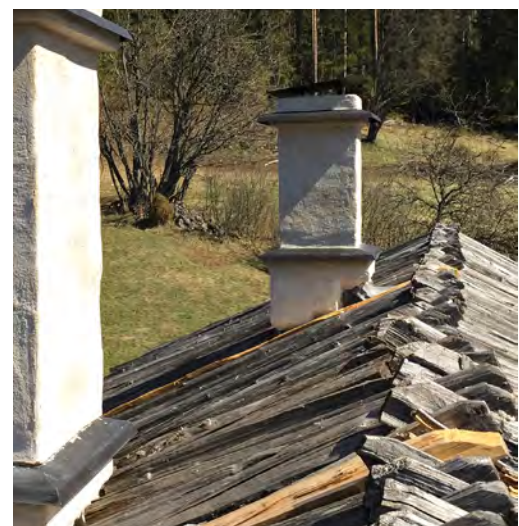
Tuvan piippu korjaustyön jälkeen vuonna 2017. Piipun hatuilla ja suojapellityksillä haettiin piipuille aiempaa pitempää käyttöikää. Esikuva hatun muodolle haettiin vanhoista valokuvista. Tuvan piipun ylileveä suojakranssi on tarkoitus vaihtaa.
