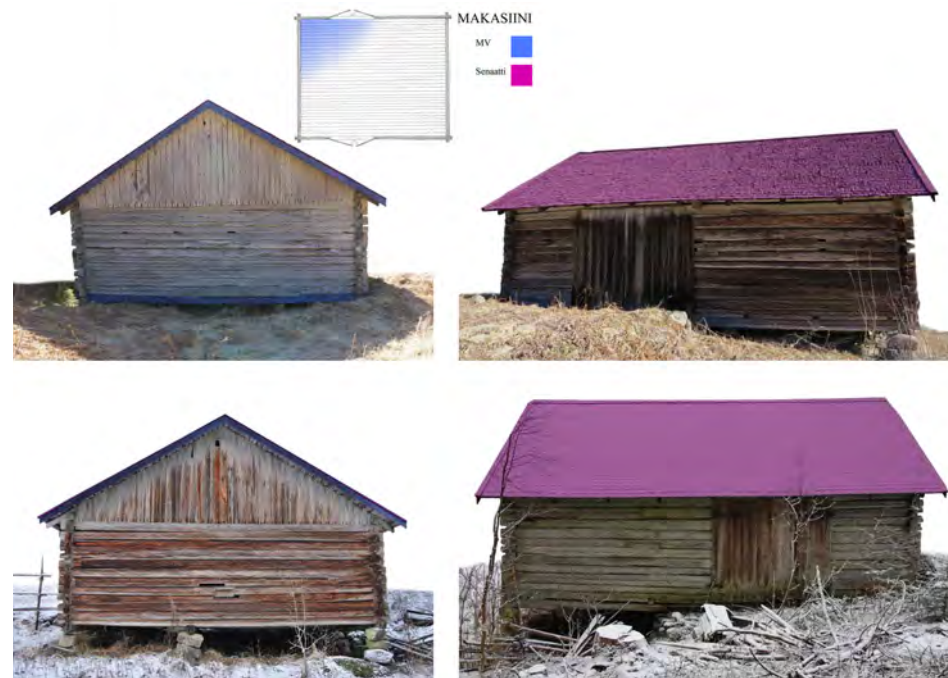
Ajoituskaavio. Vuosien 1976 ja 2013 välisenä aikana uusitut tai muokatut osat on merkitty sinisellä, vuosien 2014 ja 2018 punaisella.
