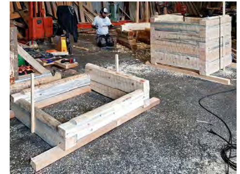
Kaivon kehää salvotaan Lintukorven verstaalla kesällä 2019. Risto Holopainen, Lintukorpi Oy.
