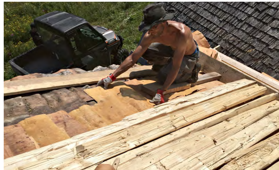
Uusi nelinkertainen tuohitus ladottiin pystyvarveina vanhan päälle ja peitettiin heti maloilla. Näin tuohien käpristyminen ei päässyt helteisenä asennusaikana alkamaan. Risto Holopainen johti malkakattotyömaata.
