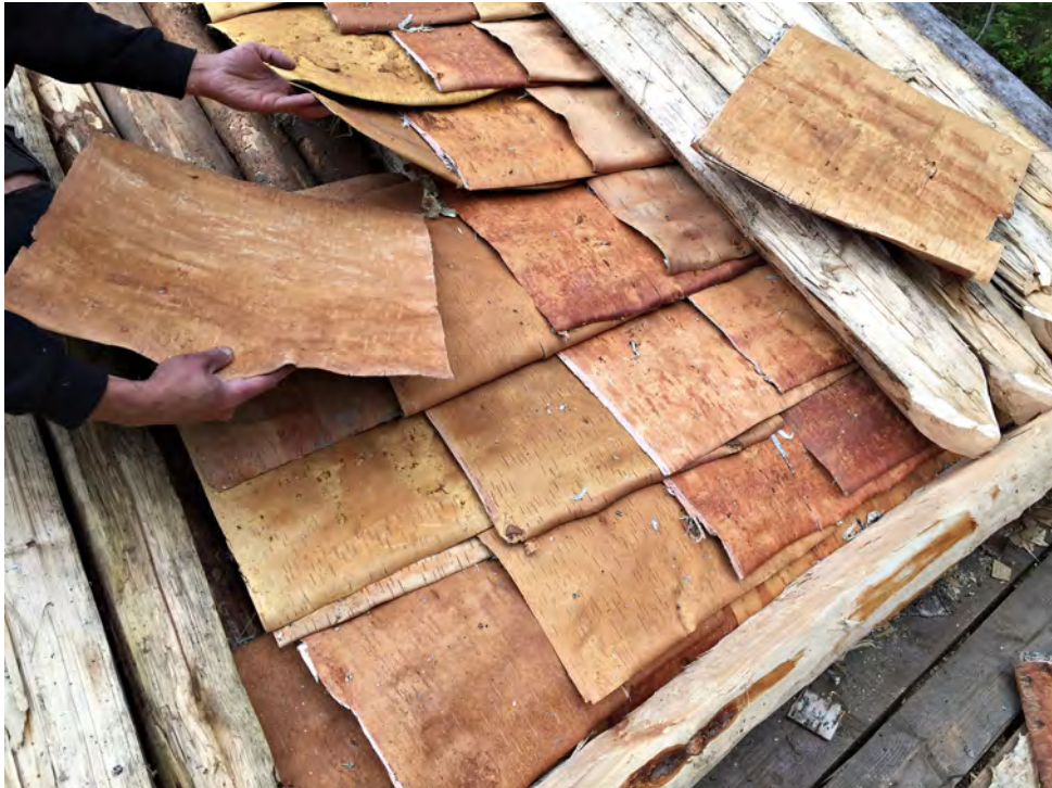
Pienen niityladon katto ladottiin pystyvarveina nelinkertaiseksi. Pystyvarveina latomisen etuna on se, että tuohet saadaan nopeammin malkojen alle. 2017.
