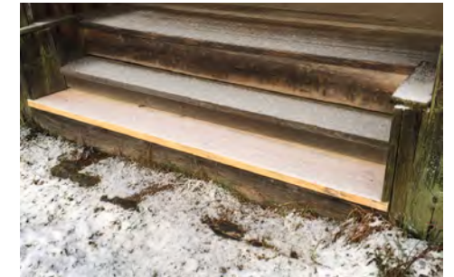
Kuistin portaiden alin astinlauta uusittiin marraskuussa 2015.
