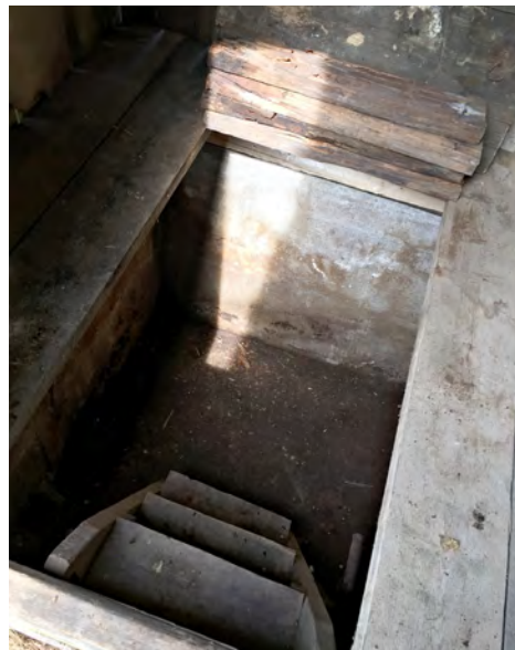
Tyhjennetty ruokakellari heinäkuussa 2015.
