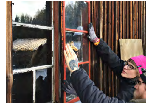
Janne ja Henna Lintukorpi asentamassa kamarin kaakkoissivun ikkunan kunnostettuja ulkopuitteita joulukuussa 2015.
