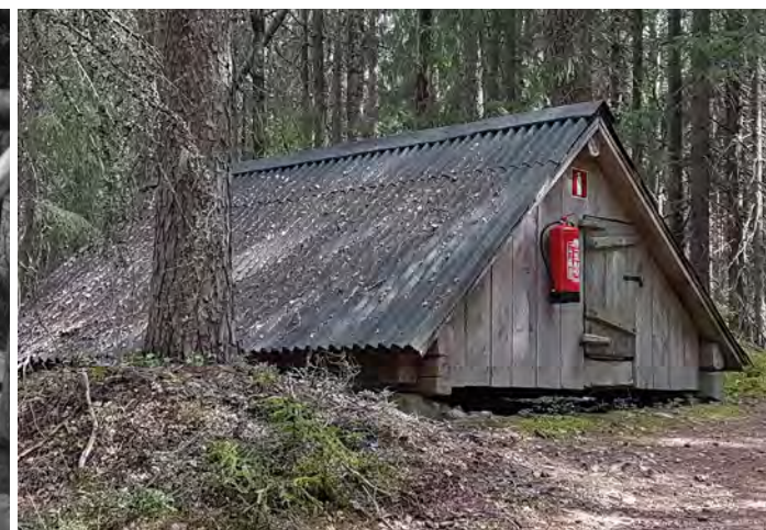
Myllymäen sammutin on asennettu maakellarin päättyyn. Lintukorpi Oy, 2021.
