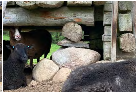
Kiukaan perustusta tuettiin asettamalla sen vastapainoksi kiviä ja maata. 2022.
