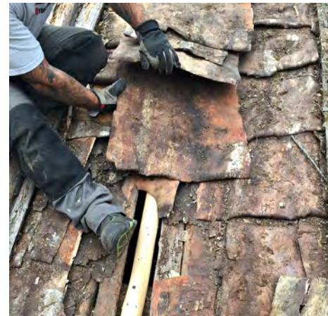
Vanha tuohitus poistettiin koukkupuiden kohdalta ja ladottiin takaisin koukkupuiden asennuksen jälkeen. 2018.
