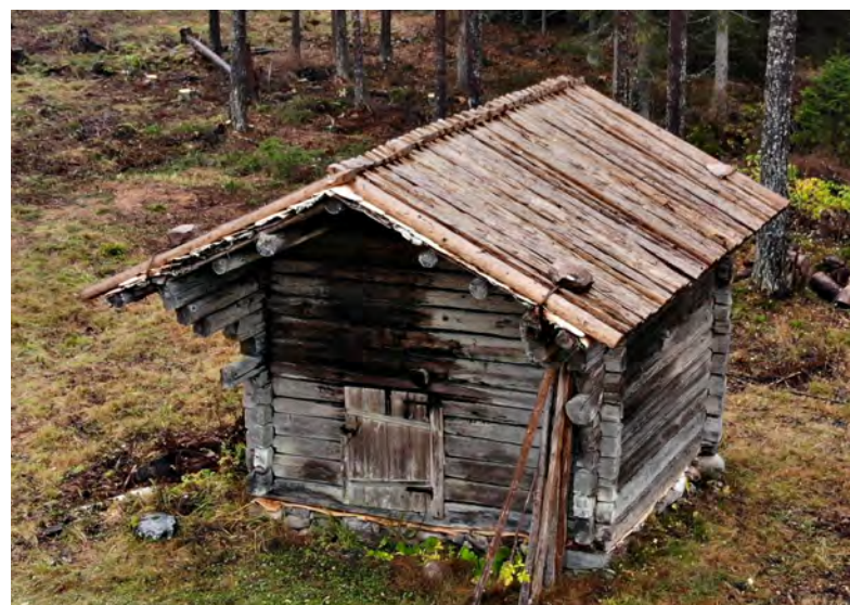
Kuvat yllä ja alla: Saunan katon reunavitsasten päät on työnnetty päällysmalkojen alle. Päällysmalkojen koholle jääminen on estetty painokivillä. 2018.
