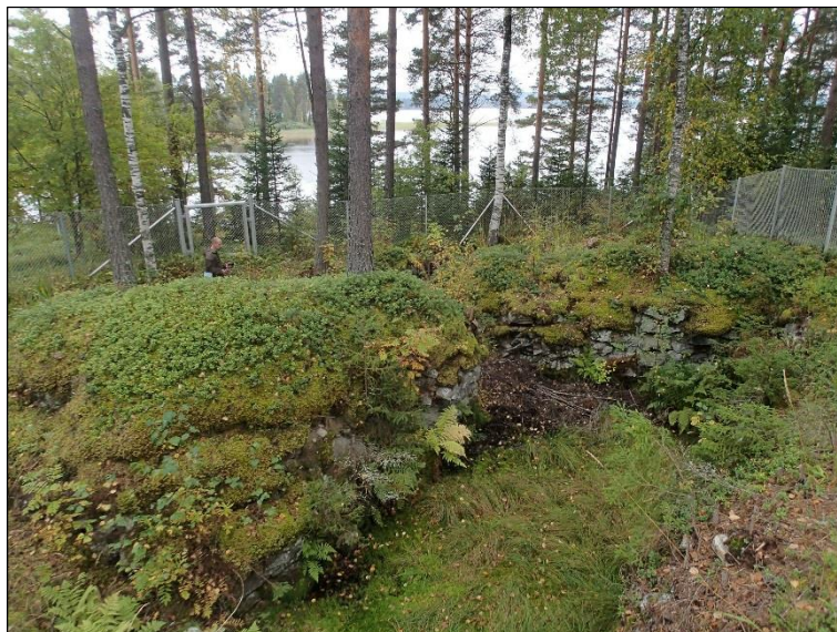
Putaansaari länsi. Kallioon louhittua suojahuonetta Putaansaassa Heikkilänlahden puolella. Taustalla Heikkilänlahtea. Kuva lounaaseen.
