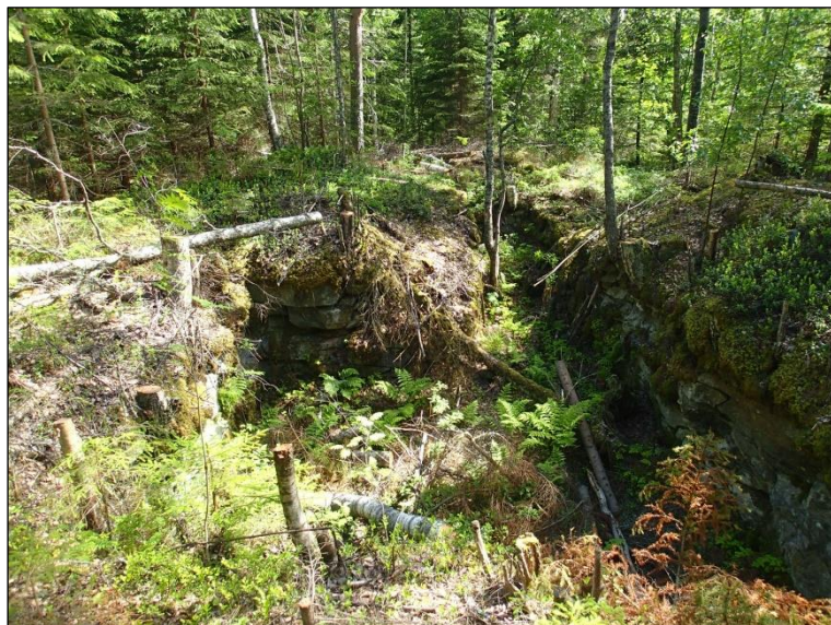
Kohteen 14 Pyytilampi koillisin korsu. Kaakkoon.
