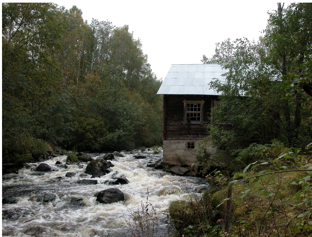
Pääskylän mylly 1 (kohde 12). Myllyrakennus alavirralla päin kuvattuna. Lounaasta.17.9.2008. TJ. (D18, PMM/KYY)
