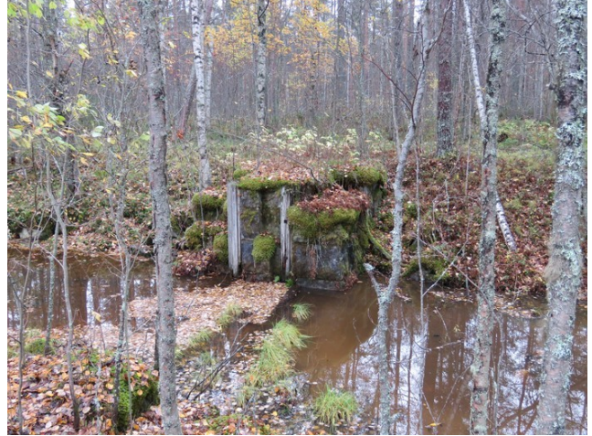
Siikajoen uittokanavan juoksutuspato kanavan itäpäässä.
