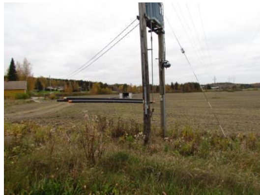
Kuva 6. Kilpijoelle asennettiin vesihuoltolinjaa syksyllä 2014.
