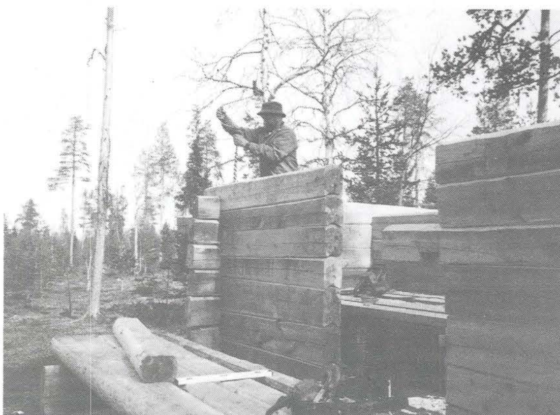
Sauna rakennettiin kuivalla maalla, josta se siirrettiin "oikealle" paikalle.
