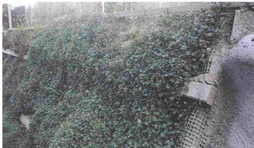
Kuva 12. Kivikkokilkkaa oli runsaasti vihreän teltan eteläpuolella 9.9.1996. Myöhemmin talven jälkeen kivikkokilkka lähes hävisi.
