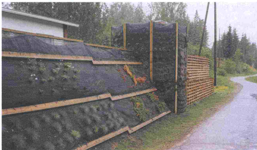
Kuva 8. Karhunnata ja tuivio vihreän teltan pohjoispuolella 19.6.1996. Ne ovat säilyneet enimmäkseen hengissä talven jäljiltä. Mustaa verkkoa näkyy kuitenkin paljon.
