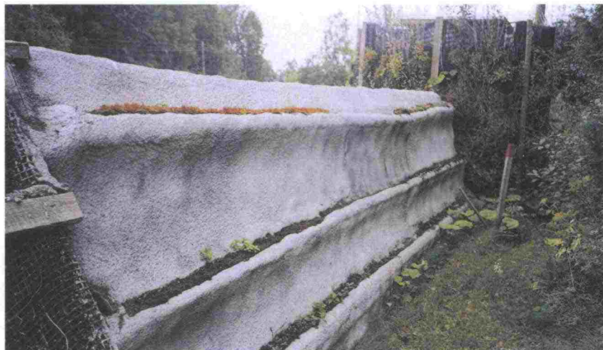
Kuva 27. Maksaruohoa jonkin verran tornissa elokuussa 1999. Maksaruoho kestää kuivuutta, mutta rikkaruohot tahtovat syrjäyttää sen. Betonimuurissa oli sammalta.
