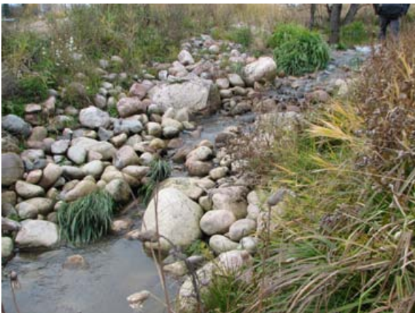
Pienimuotoinen pohjapato sopii esimerkiksi ojiin tehtäviin peräkkäisten altaiden välille.
