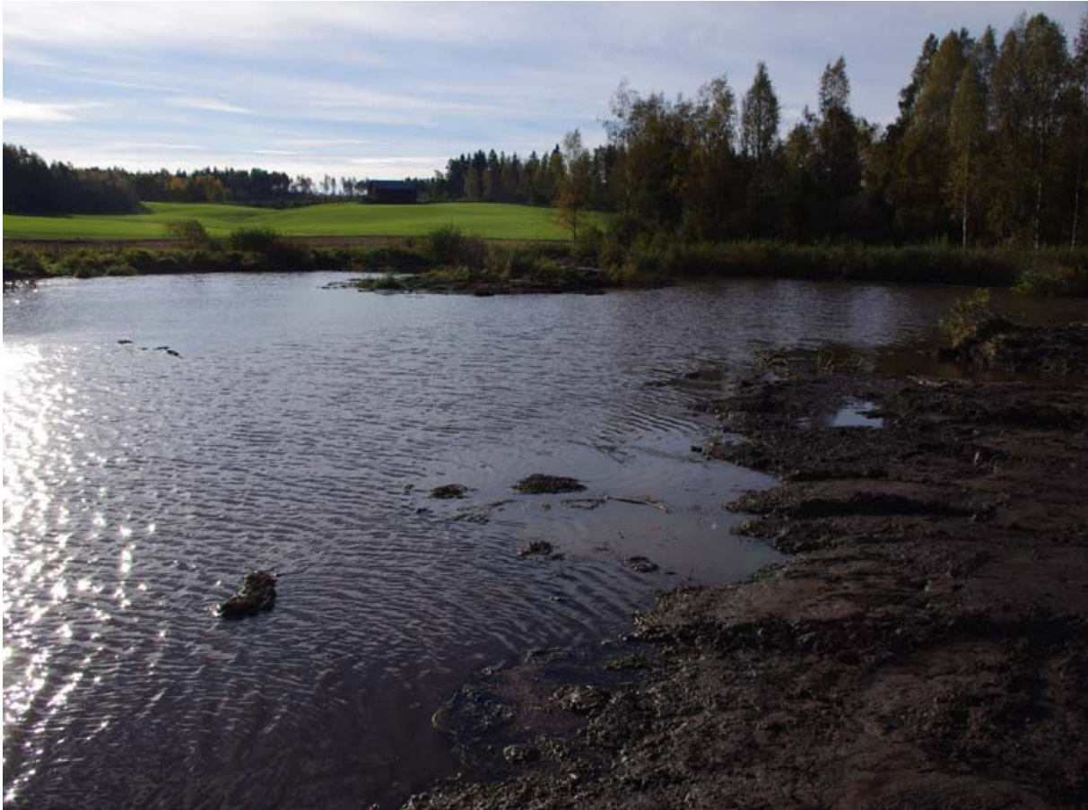
Kosteikko voidaan toteuttaa esimerkiksi johtamalla osa joen vesistä altaaseen, jolloin virtaus hidastuu ja ainakin osa kiintoaineesta laskeutuu. Yleensä kasvit leviävät altaan ympäristöön yhdessä kesässä, vaikka reunat olisivatkin rakentamisen jälkeen täysin paljaita. Kuva: Ilkka Myllyoja
