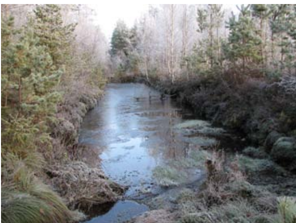
Tyypillinen laskeutusallas. Se toimii parhaiten siellä, missä maa-aines laskeutuu nopeasti ja siksi usein käytössä metsäojitusten vesiensuojelussa. Sivun kuvat: Anni Karhunen
