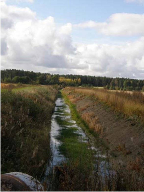
Perattua ojaa. Tässäkin tapauksessa alivesiuoma, tulvasanteet ja reunojen loivennus olisivat voneet olla parempi ratkaisu ja ojan pohjan nopea ruohottuminen estynyt.
