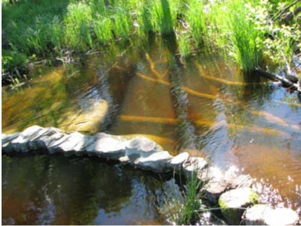
Veden virtausta hidastamaan ja ohjaamaan riittävät joskus puupaalutkin.
