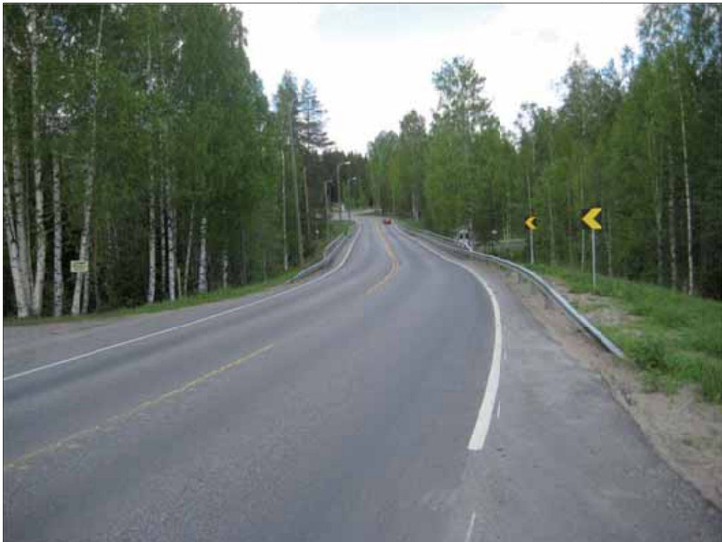
Kuva 2-6. Lastukosken sillat lännestä. Vaikka siltojen hyötyleveys vastaa tien leveyttä, sillat vaikuttavat ahtailta varsinkin, kun kevyen liikenteen väylää ei ole. Siltojen takana on jyrkkä mutka vasemmalle.
