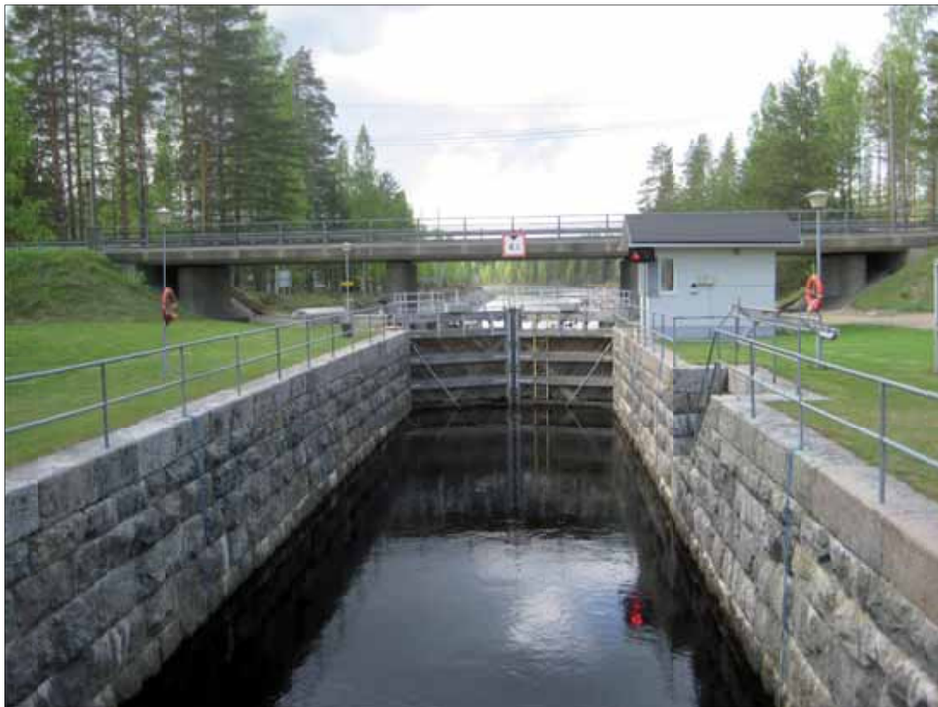
Kuva 2-4. Lastukosken kanavasillan matala 4,3 metrin alikulkukorkeus rajoittaa Syvärille pääsevien alusten kokoa. Kanavan alapuolelle pääsee 8 metrin korkuisilla aluksilla. Lastukosken kanava on rakennettu vuonna 1906. Nykyisin itsepalveluperiaatteella toimivan sulun pituus on 30 metriä, leveys 7 metriä ja kulkusyvyys 1,4 metriä.
