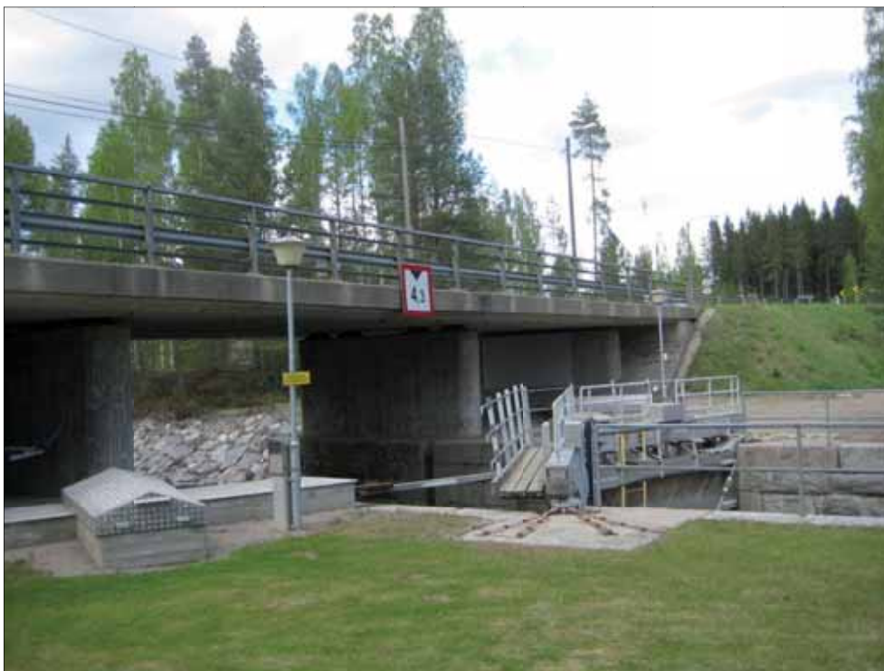
Kuva 4-5. Nykyiset sulkuportit eivät ole riittävä ratkaisu kevyen liikenteen väyläksi, vaan vesiliikenteen alikulkukorkeuden nostaminen 8 metriin edellyttää uutta kevyen liikenteen siltaa nykyisen kanavasillan paikalle.
