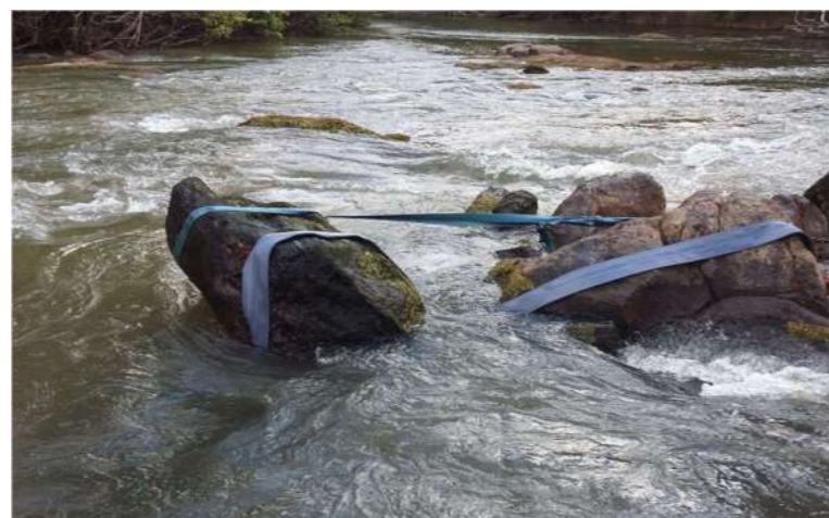
Figure 2 : Déplacement de blocs au tire-câble au saut Moula [décembre 2015]
