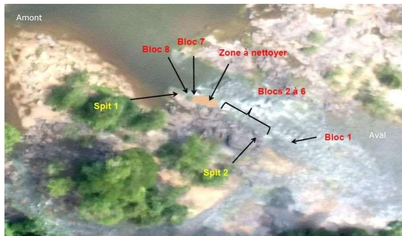
Figure 67 : Localisation des zones de travaux au saut Oulpaléya Itou (vue aérienne)
