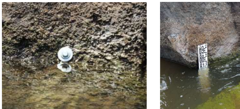
Figure 138 : Exemples de repère altimétrique et d'échelle de niveau au saut Moula [septembre 2014]
