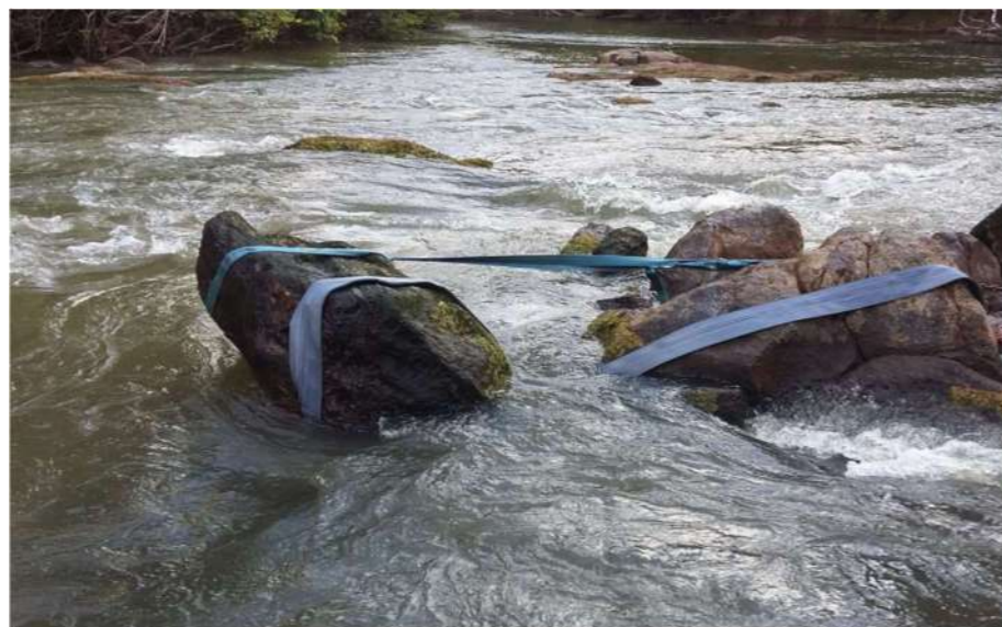
Figure 8 : Déplacement de blocs au tire-câble au saut Moula [décembre 2015]
