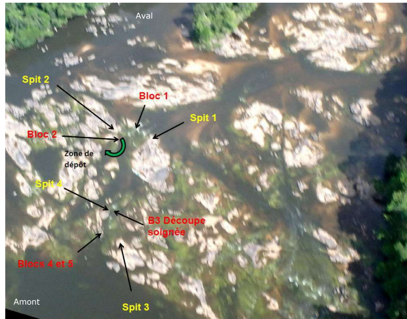
Figure 52 : Localisation des zones de travaux au saut Alalio (vue aérienne)
