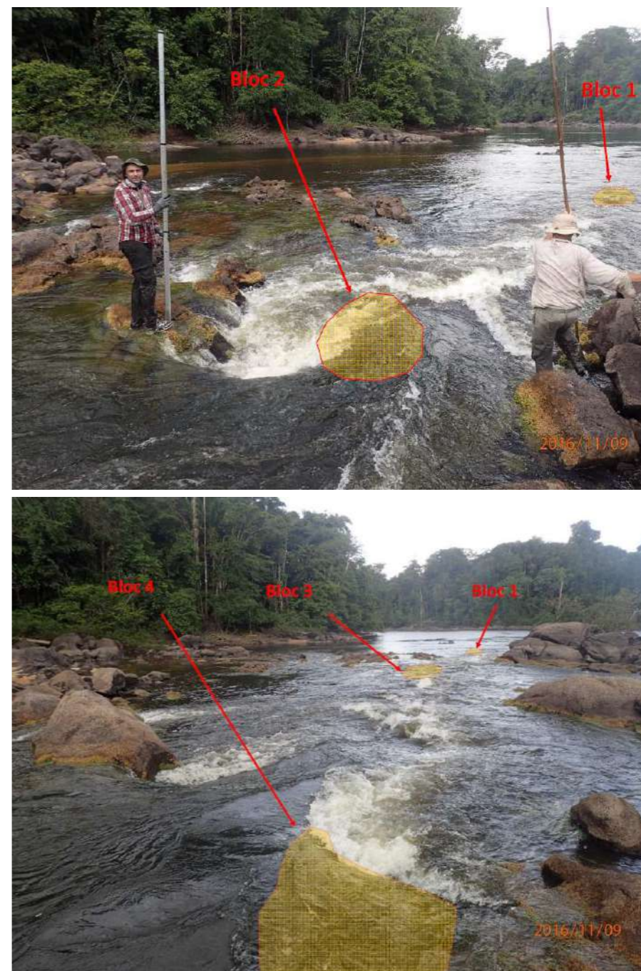
Figure 37 : Zones de retraits ponctuels (4 blocs) au saut Matinon Kangué Itou
