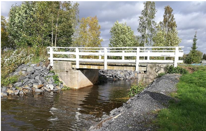
Kuva 10. Sonnisaareen johtava silta.
