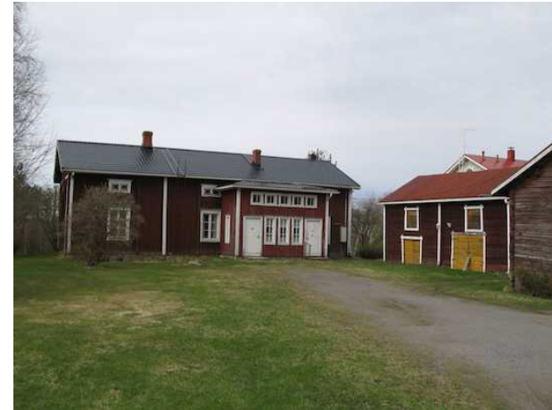
Yli-Luukon vanha päärakennus, sen oikealla puolella talli ja puori-liiverirakennuksen päätyä.
