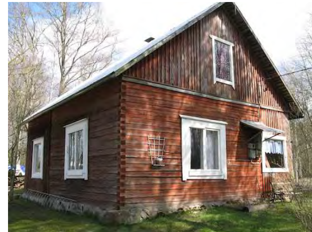
Tyypillinen 1800-1900-lukujen taitteen hirsirunkoinen torppa, jota on myöhemmin laajennettu rankorakenteisilla osilla.
