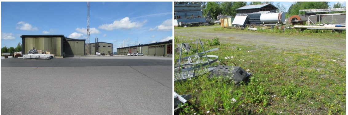
Kuvat 4-1 ja 4-2. Sataman ja tukikohdan aidatun alueen asfalttipiha ja rakennuksia sekä sora-kentän varastoalue.
