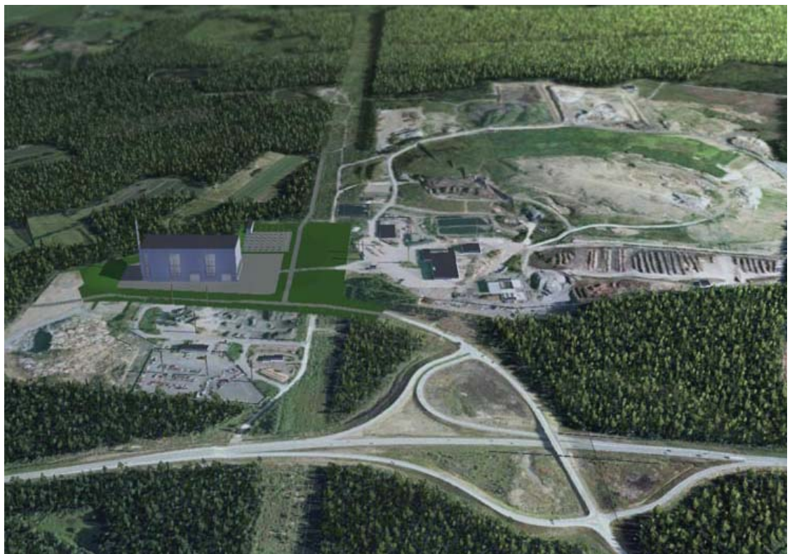
Kuva 102. Ilmakuvasekvenssi Tarastenjärven hyötyvoimalaitoksen sijoittumisesta jätteenkäsittelykeskuksen kupeeseen.
