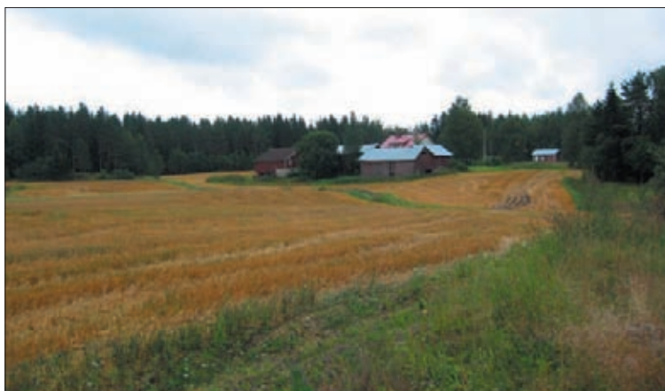
Kuva 24. Ojalan tilan rakennuksia.
