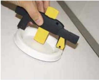
KUVA 1. KSO- poistoilmaventtiin avautumisasennon mittaaminen mittaustulkilla. (8)
